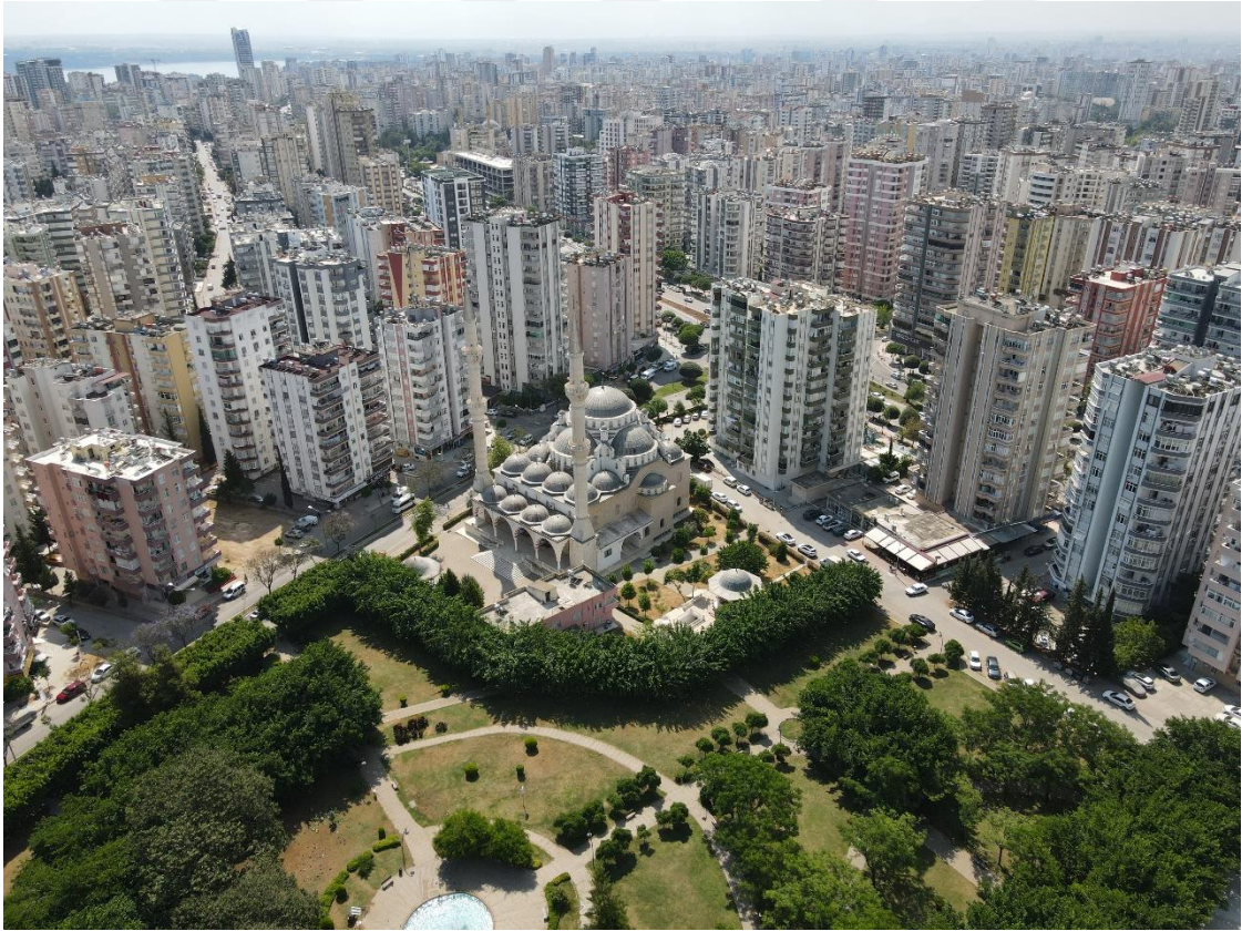
Fotoğraf 44. Toros ve Güzelyalı Mahallelerinden Bir Görünüm
