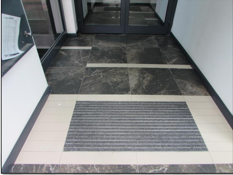
Şekil 24. Bina Girişindeki Kirletici Önleyiciler (Araştırmacı, 2019)
