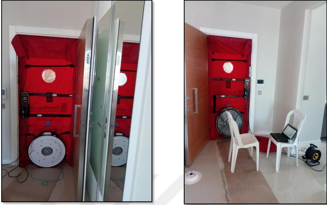
Şekil 14. Blower (basınç) Door Testi (Ekho Sızdırmazlık, 2018)
