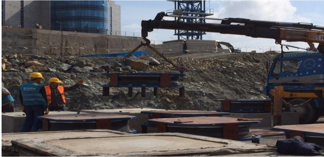
Şekil 4.2. Hastane Projesi sismik izolatör yerleştirilme anı
