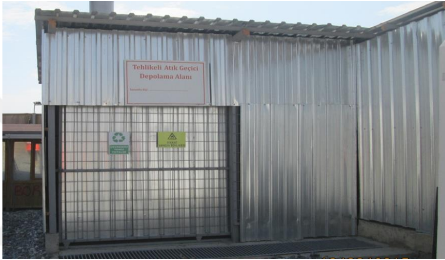
Şekil 4.3. Tehlikeli atık geçici depolama alanı
