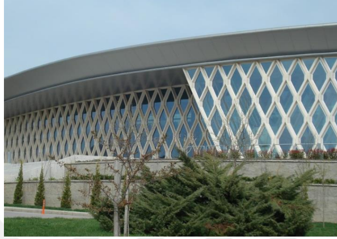
Şekil 2.11. Sabancı üniversitesi nanoteknoloji binası (URL-43)
