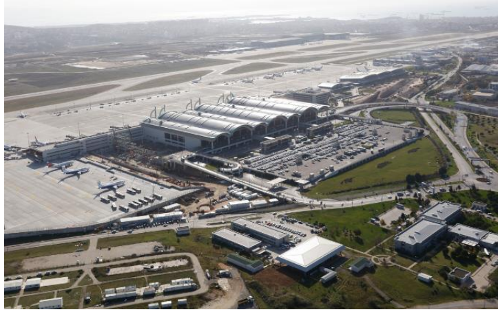
Şekil 2.5. İstanbul sabiha gökçen uluslararası havalimanı terminal binası (URL-36)
