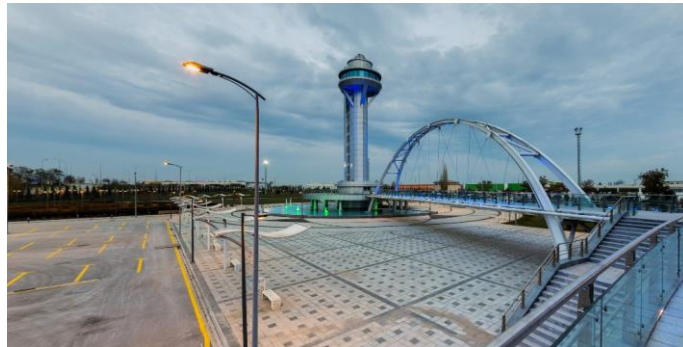
Şekil 3.4. Gözlem kulesi giriş (URL-61)
