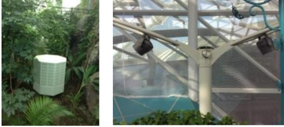
Şekil 3.15. KBBM nem ve sıcaklık kontrolü sağlayan cihazlar
