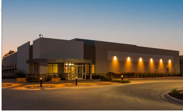
Şekil 2.18. Toyota inland empire training center binası (URL-52)
