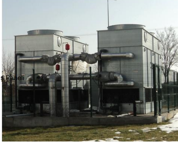
Şekil 3.7. Soğutma kuleleri
