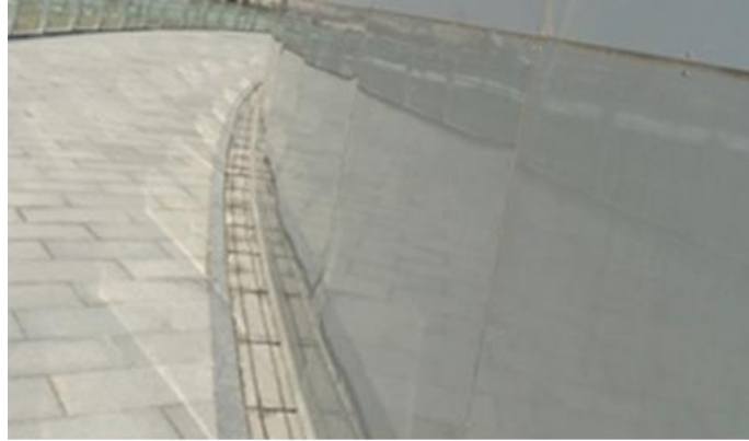
Şekil 3.6. Yağmur suyu kanalı
