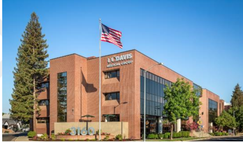
Şekil 2.20. UC davis medical group midtown clinic binası (URL-54)
