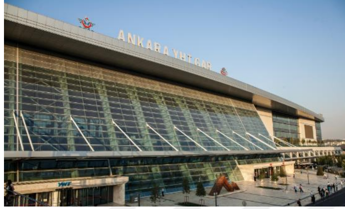
Şekil 2.7. Ankara yüksek hızlı tren garı binası (URL-38)
