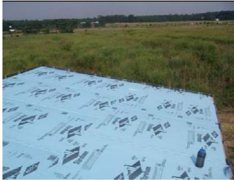
Şekil 3.7 Isı yalıtım tabakası (Ancaya, b.t)
