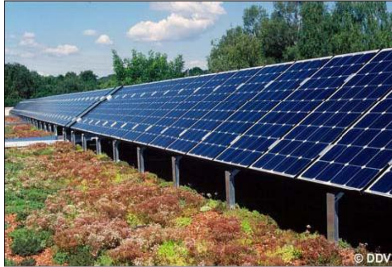
Şekil 3.2 Ekstansif yeşil çatı ile birleştirilmiş fotovoltaik panel uygulaması, Stuttgart yakınlarında bir okul (Ansel ve diğer., 2004)
