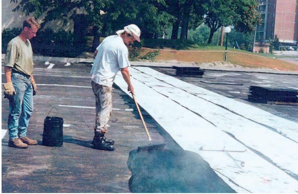
Şekil 3.6 Sıcak uygulanan likid membran (Henshell, 2005)
