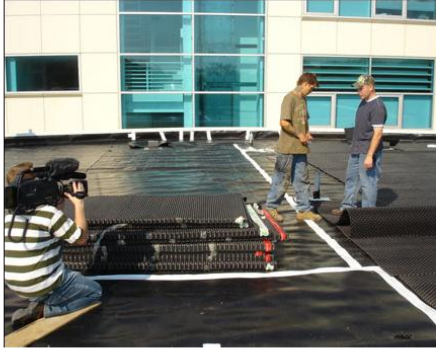
Şekil 3.8 Kök tutucu tabaka ve direnaj tabakası (Stater, bt.)
