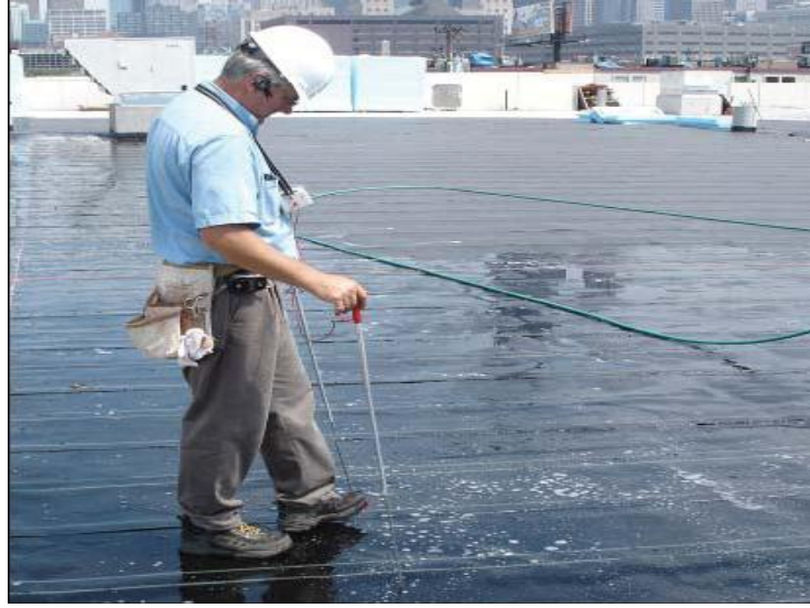
Şekil 3.34 American Hydrotech firması kaçak testi uygulaması (Tolderlund, 2010)
