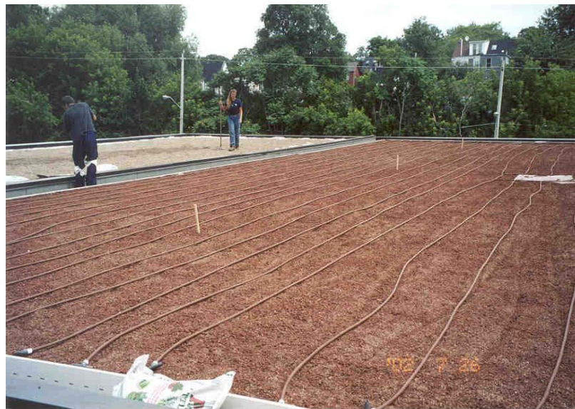
Şekil 3.31 Damlama sulama sistemi (Liu ve Baskaran, b.t)
