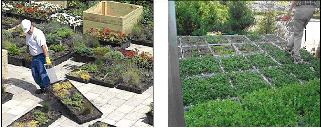
Şekil 3.22 Modüler yeşil çatı sistemi (Dinsdale ve diğer., 2006)
