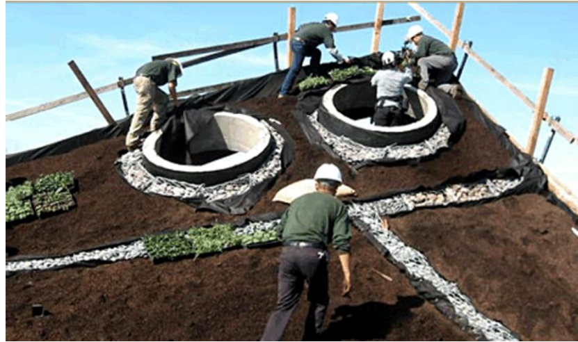
Şekil 4.10 Yeşil çatı yetiştirme ortamı ve drenajları (The Osher living roof, b.t)
