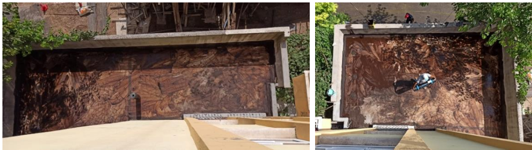
Şekil 3.11. Su yalıtımı için astarın uygulanması
