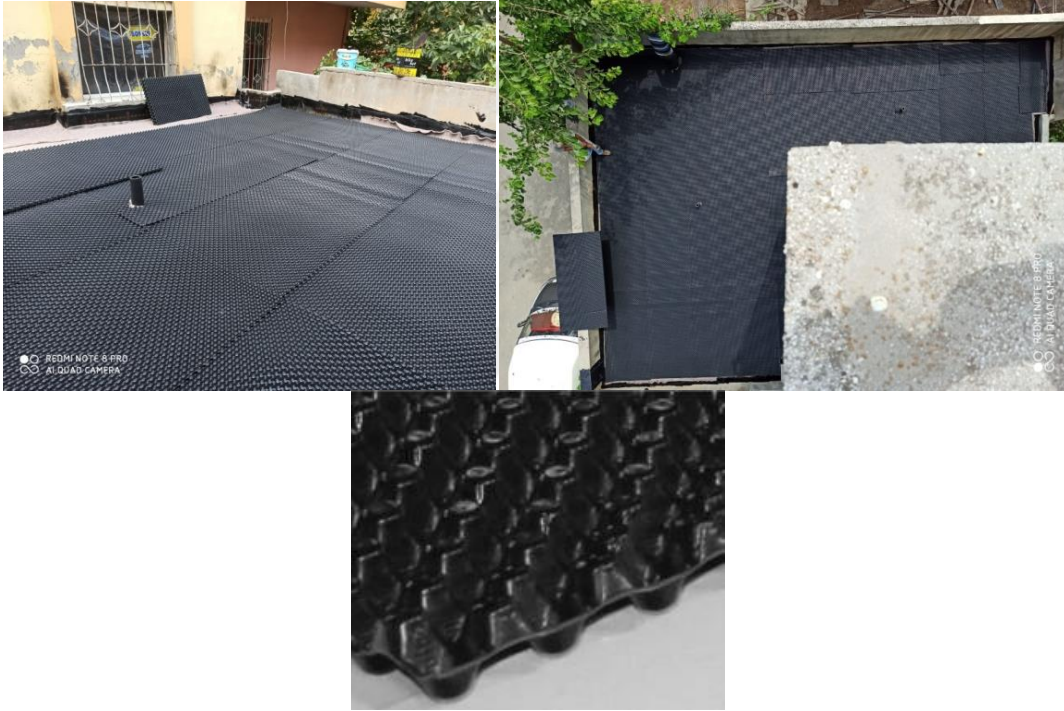
Şekil 3.16. Drenaj levhalarının yerleştirilmesi
