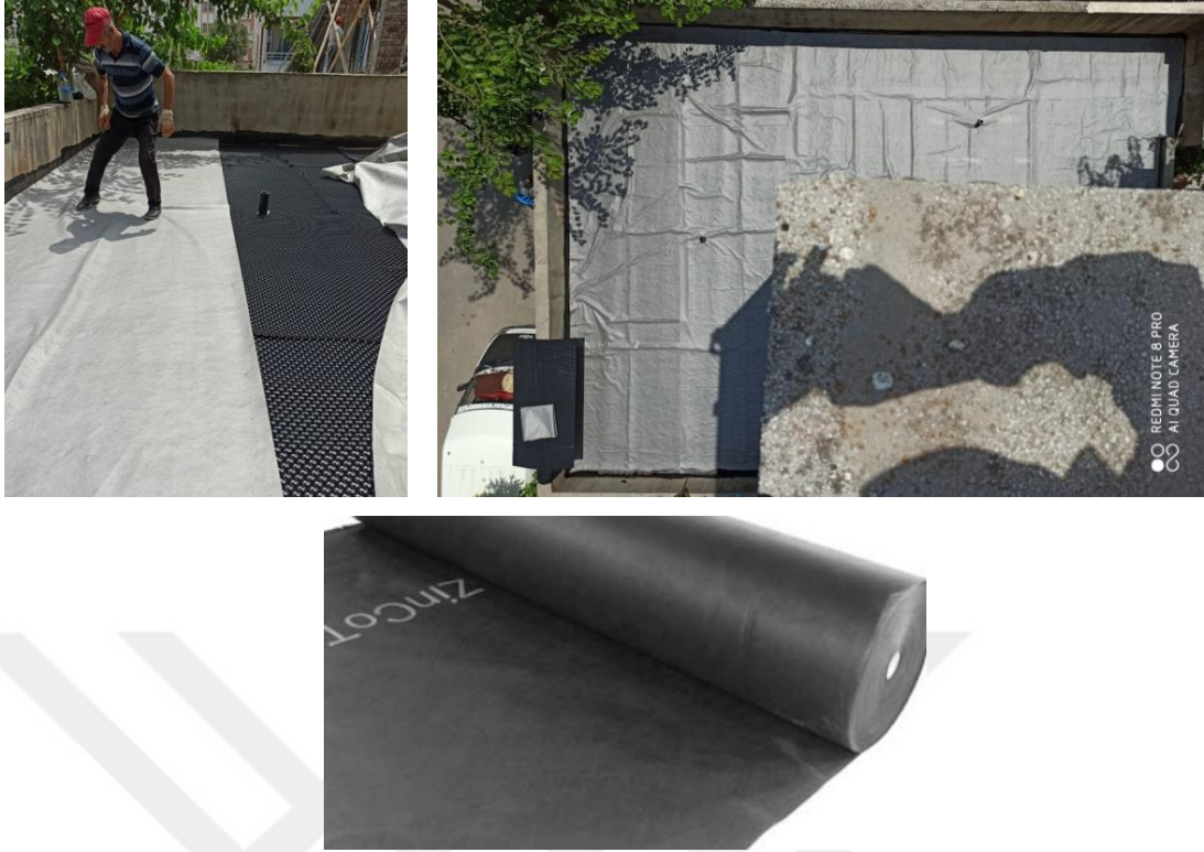
Şekil 3.17. Sistem filtresinin serilmesi
