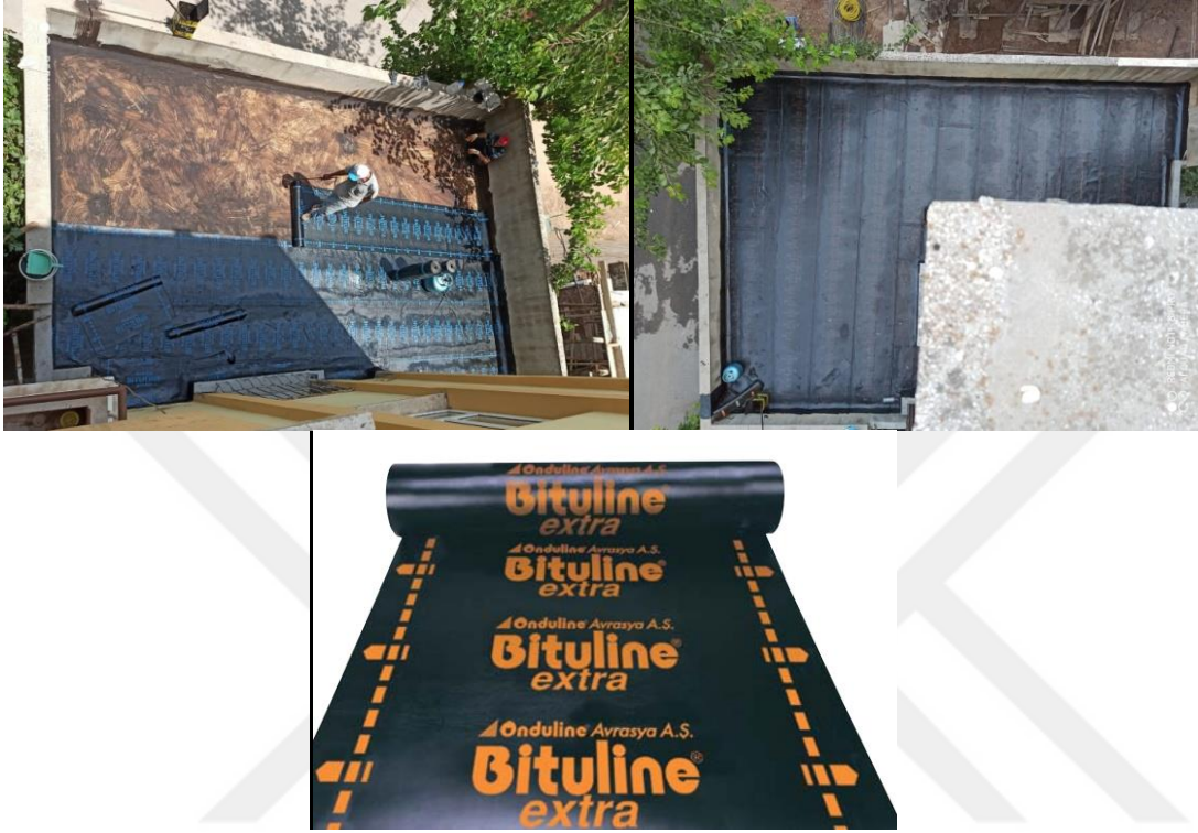
Şekil 3.12. Çift kat su yalıtımının uygulanması
