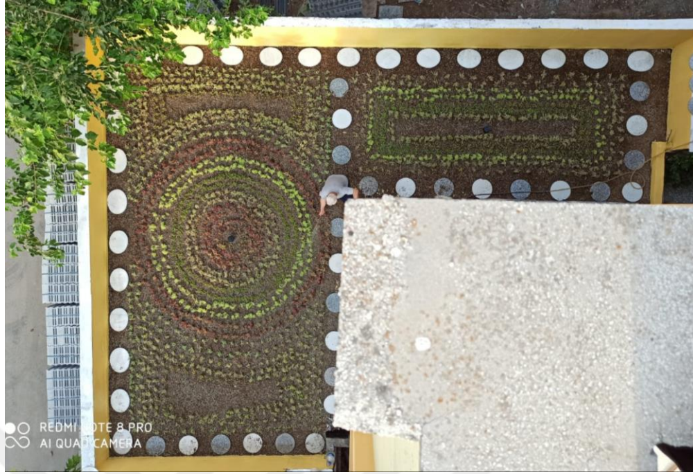
Şekil 3.20. Tercih edilen sedum tipi bitkilerin tasarlanan şekilde ekiminin yapılması
