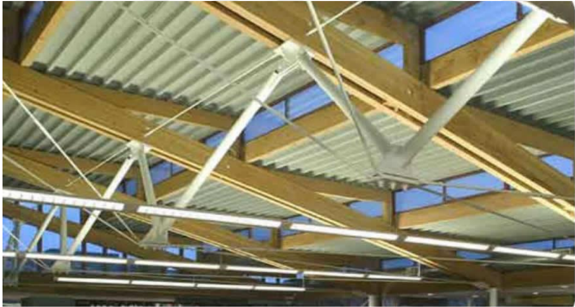
Resim 3.12. Çatı pencereleri örneği
