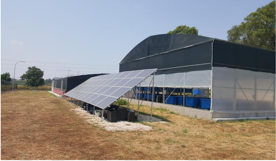
Şekil 4.2. Denemenin kurulu olduğu 200 m 2 boyutunda sera, 10 KW elektrik üretebilen solar sistem ve sera içerisinde bulunan resirküle sistemin sera dışından görünümü
