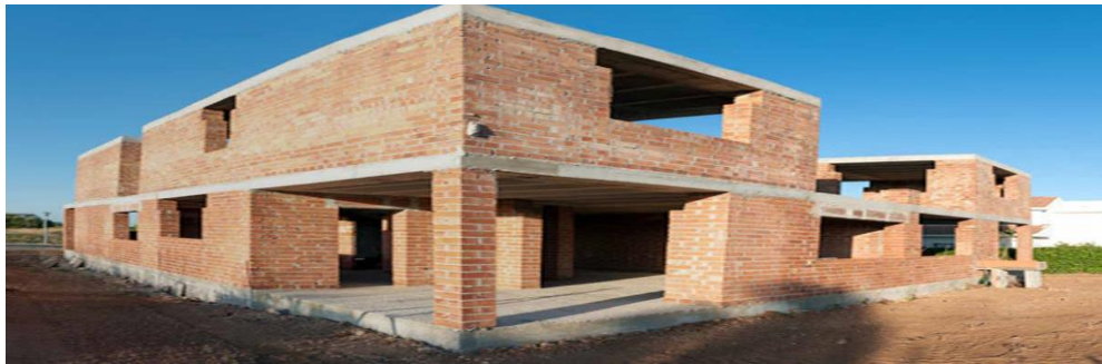
Şekil 2.22. İnşa halindeki bir yığma yapı görünüşü
