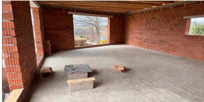
Şekil 2.16. Yığma yapıda betonarme döşeme örneği
