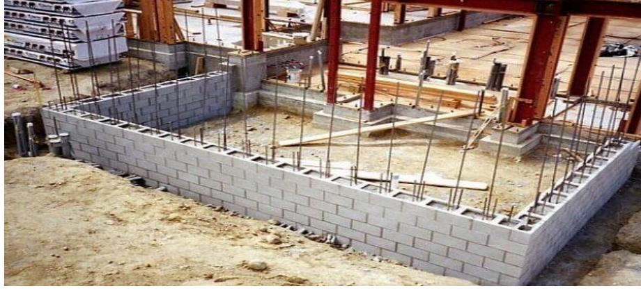
Şekil 2.21. Donatılı yığma duvar örneği
