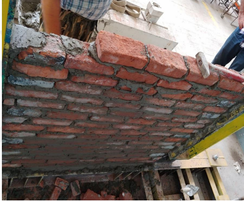
Şekil 2.24. Harman tuğla duvarı yapımı inşaat süreci
