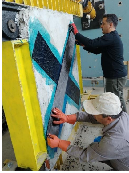
Şekil 2.41. Duvara karbon levhaların uygulanması
