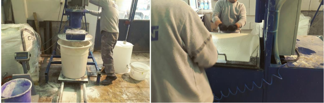
Resim 4.1. Püskürtme beton karışım anı.
