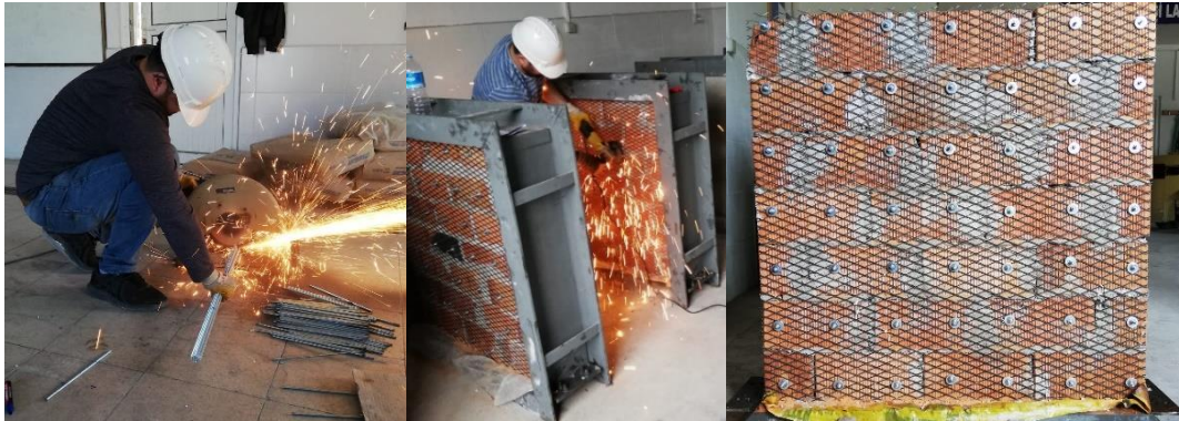
Şekil 4.16. Duvarlarda güçlendirme işlemleri - ankraj uygulaması
