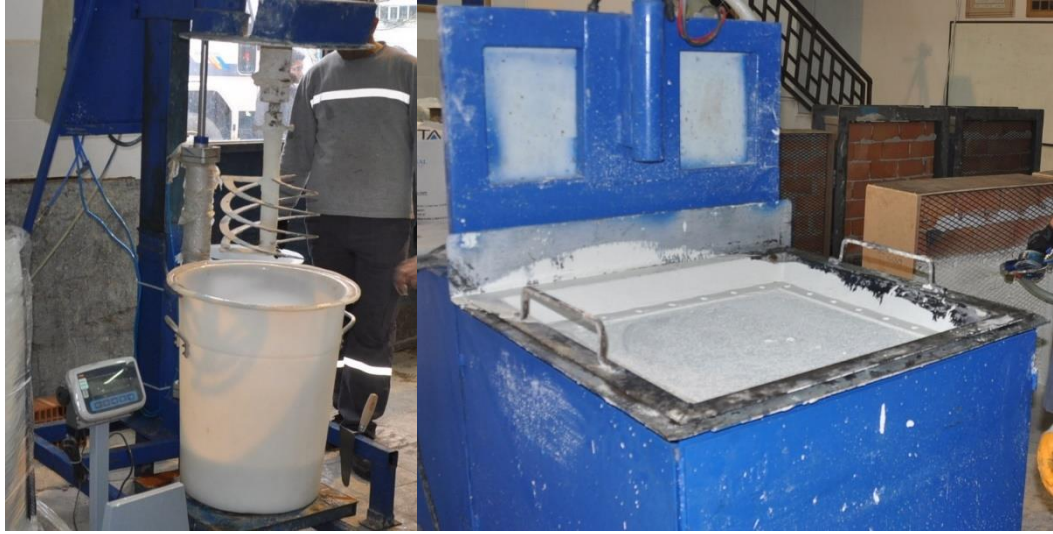
Şekil 5.1. Püskürtme beton karışımının hazırlanması
