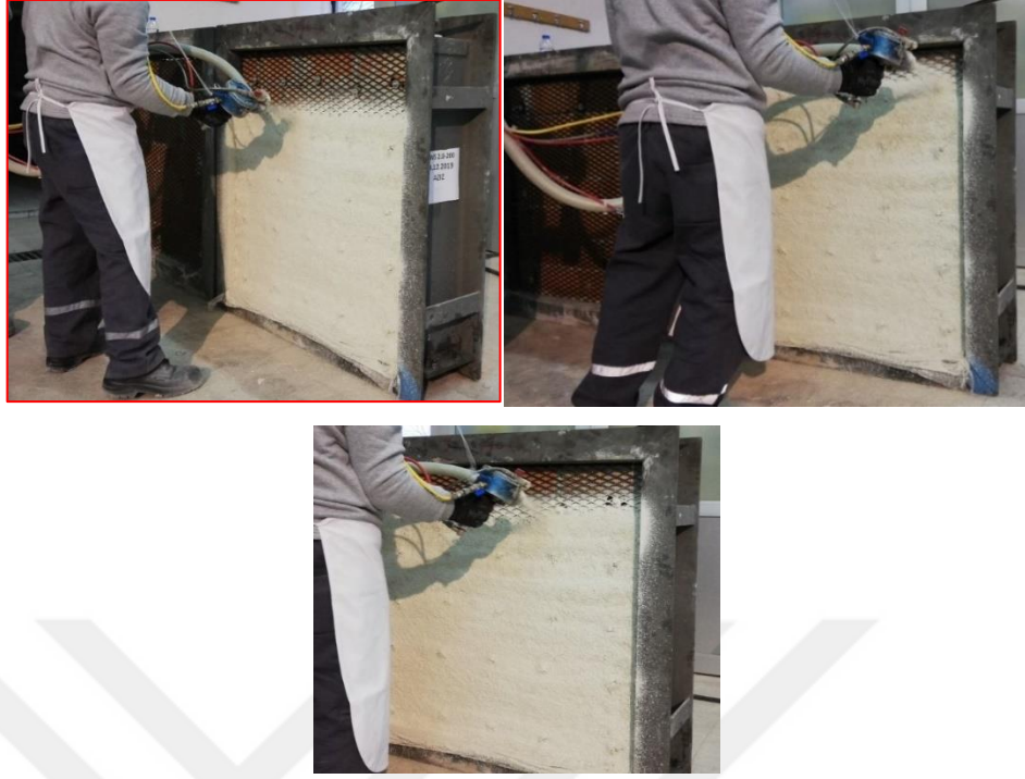
Şekil 5.3. Duvarlara cam lif katkılı püskürtme beton uygulaması
