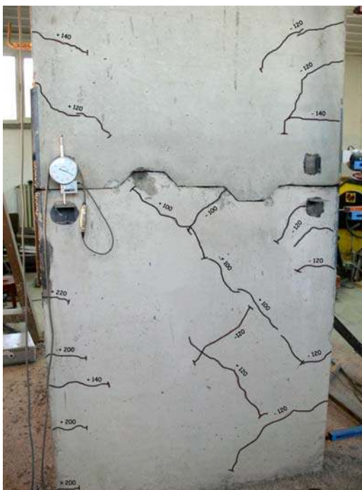
Resim 4.14. 200kN yük altında oluşan çatlaklar
