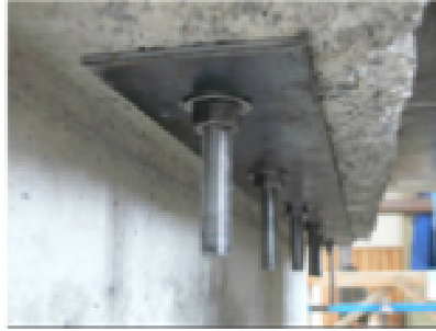
Resim 4.1. Bağlantı çubuklarının açılan deliklere epoksi ile yerleştirilmesi
