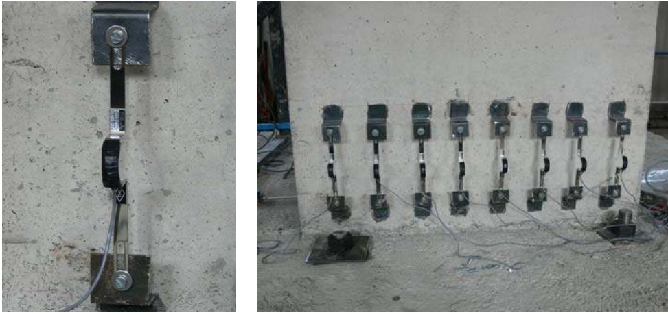
Resim 4.17. Çatlak ölçer düzeneği
