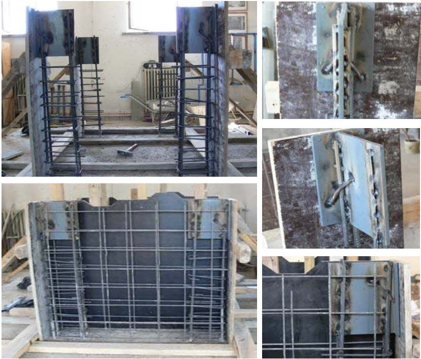
Resim 4.9. Birleşimde kullanılan levhaların gösterimi
