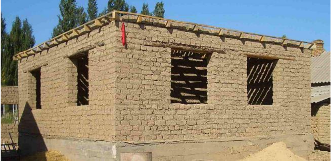
Şekil 1.7. Kerpiç yapı örneği
