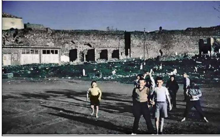
Şekil 46. Aşağıhisar surları yanındaki Moloz mezarlık alanının metruk durumu, 1960 (Kamil Gündoğdu arşivi, 2022)
