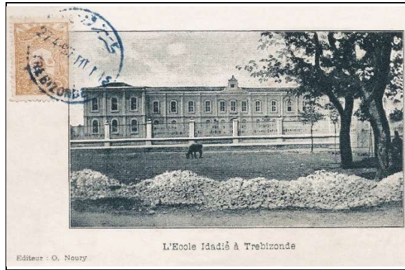
Şekil 118. Yıkılan Mekteb-i İdadi, 1900-1910 (Ali Işık arşivi, 2019)
