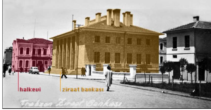
Şekil 11. Trabzon Halkevi Binası ve karşısında Maraş Caddesi’ndeki kilisenin yerinde bulunan bugünkü Ziraat Bankası (Fuat Demircioğlu arşivi, 2021)
