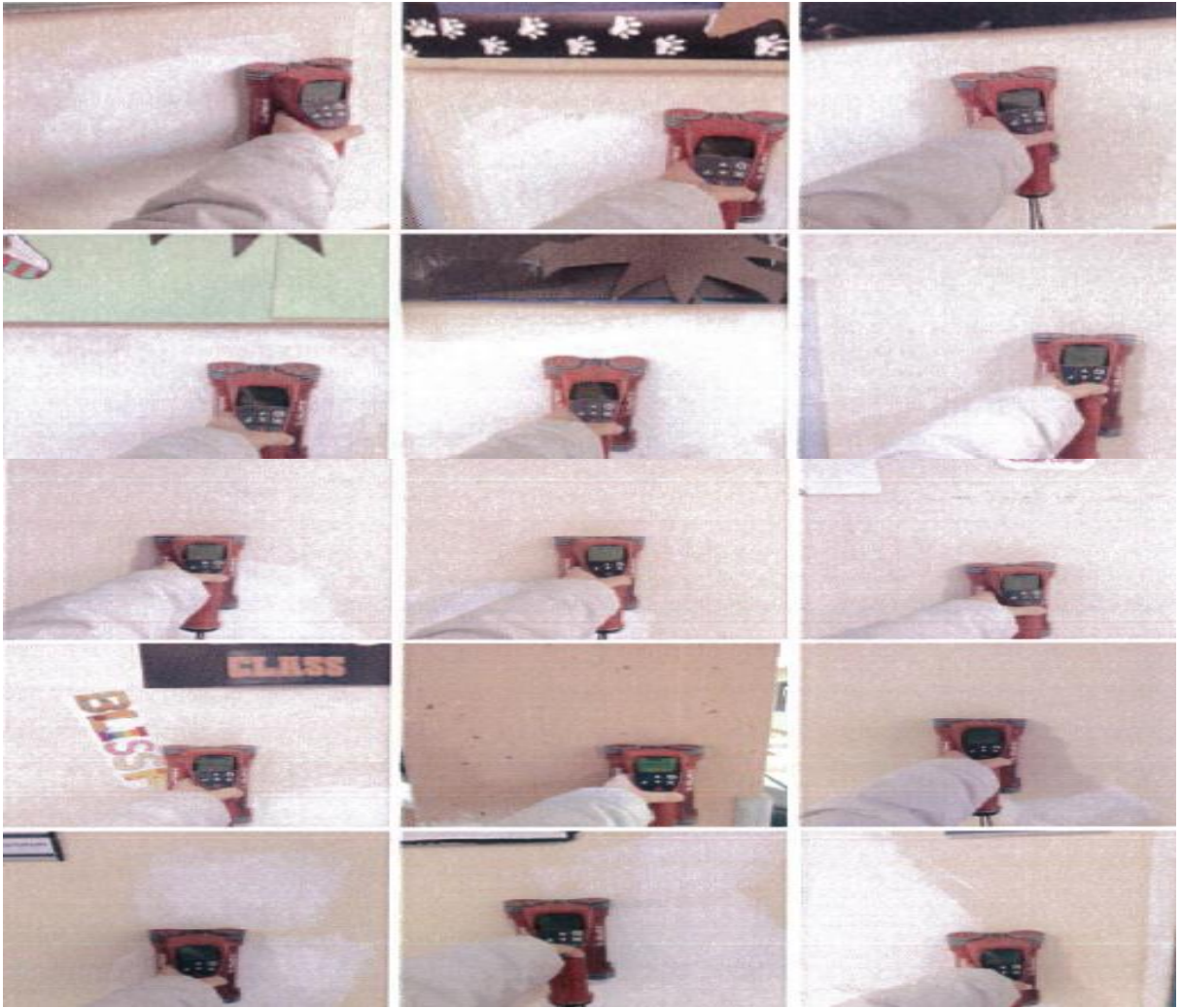
Şekil 22. Belirlenen bazı taşıyıcı elemanlara ait donatı okumaları
