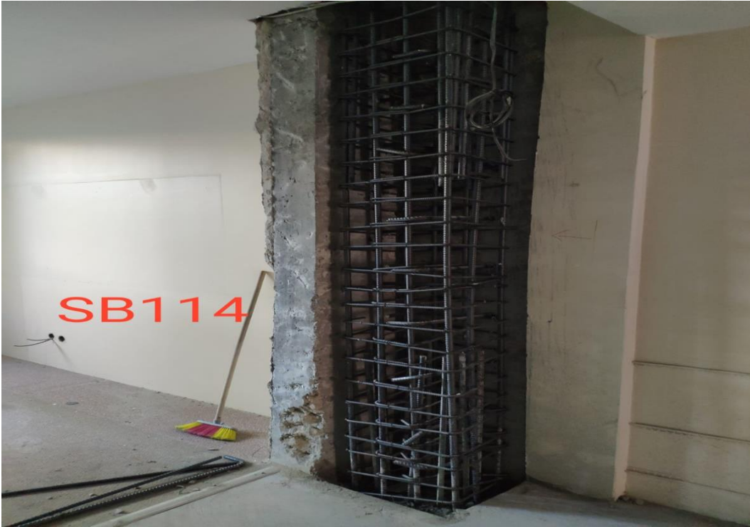
Şekil 26. L kesitli kolonda gerçekleştirilen mantolama işlemi
