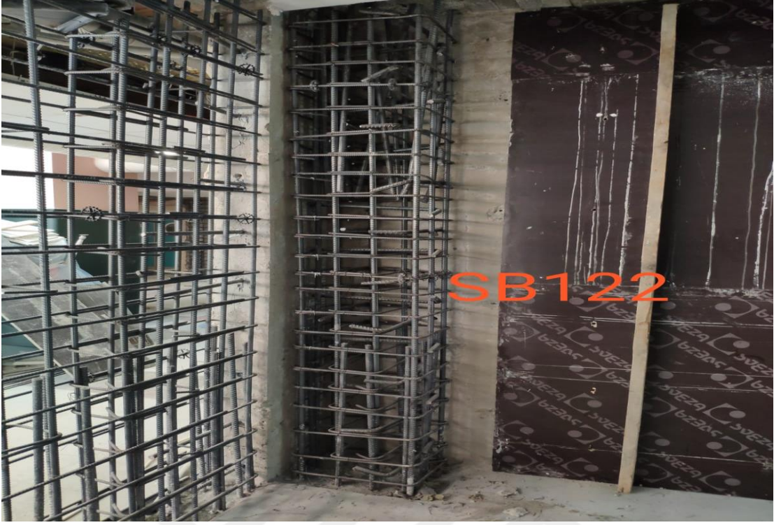
Şekil 27. Kolonda mantolama ve perde ilavesi uygulaması
