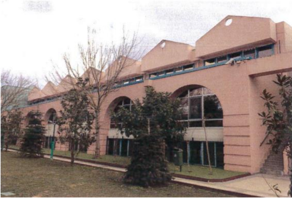
Şekil 18. A-2 blok yan cephe görüntüsü
