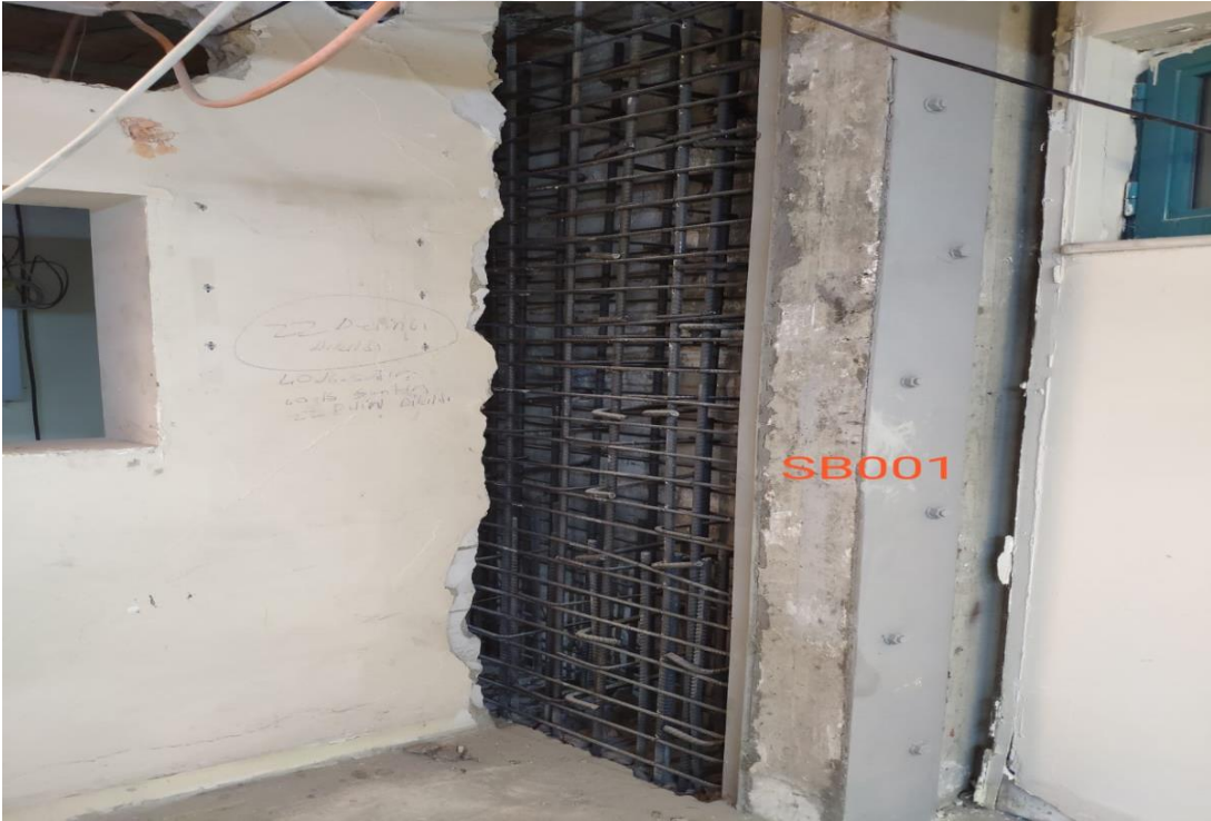
Şekil 28. Epoksi uygulaması ile mantolama işlemi
