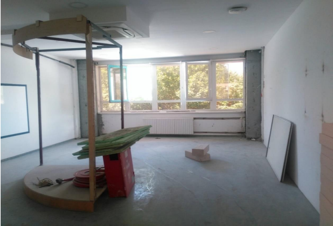
Şekil 30. Güçlendirme sonrası kolonlarda yapılan mantolama işlemler
