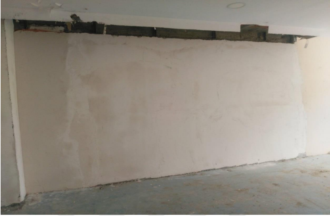
Şekil 29. Güçlendirme sonrası yapılan çalışmalar
