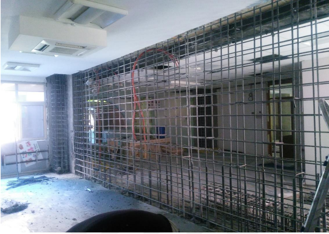
Şekil 25. Kolonlar arasında epoksi ile perde uygulaması
