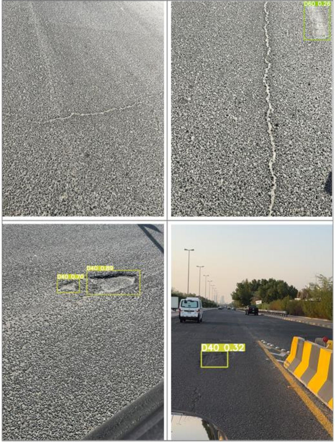
Şekil EK-1.20. Kuveyt ülkesine ait kusur algılama sonuçları
