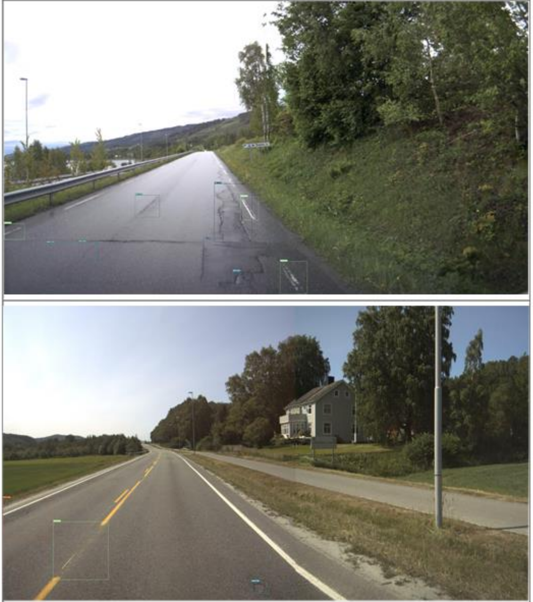
Şekil EK-1.14. Norveç ülkesine ait kusur algılama sonuçları
