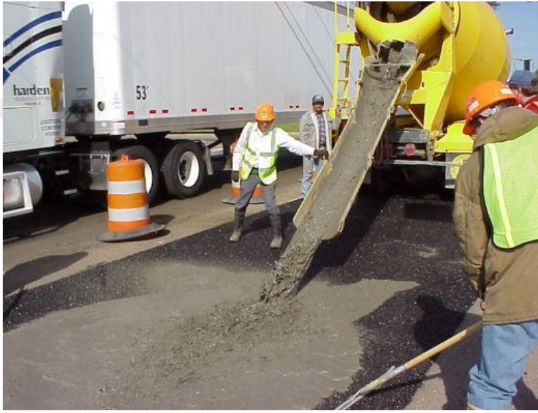
Şekil 2.2. Yarı rijit kaplamada kullanılan akışkan harç (Randy 2007)
