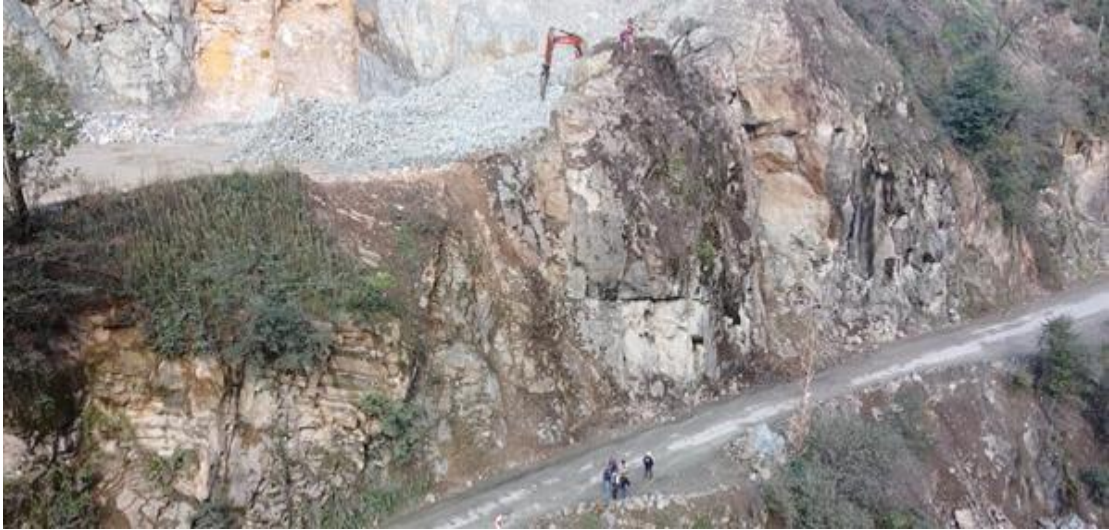
Şekil 5. KM: 09+900 – 10+100 güzergâhında bulunan düzlemsel kayma ve kama tipi kayma riski yüksek olan kaya kütleleri
