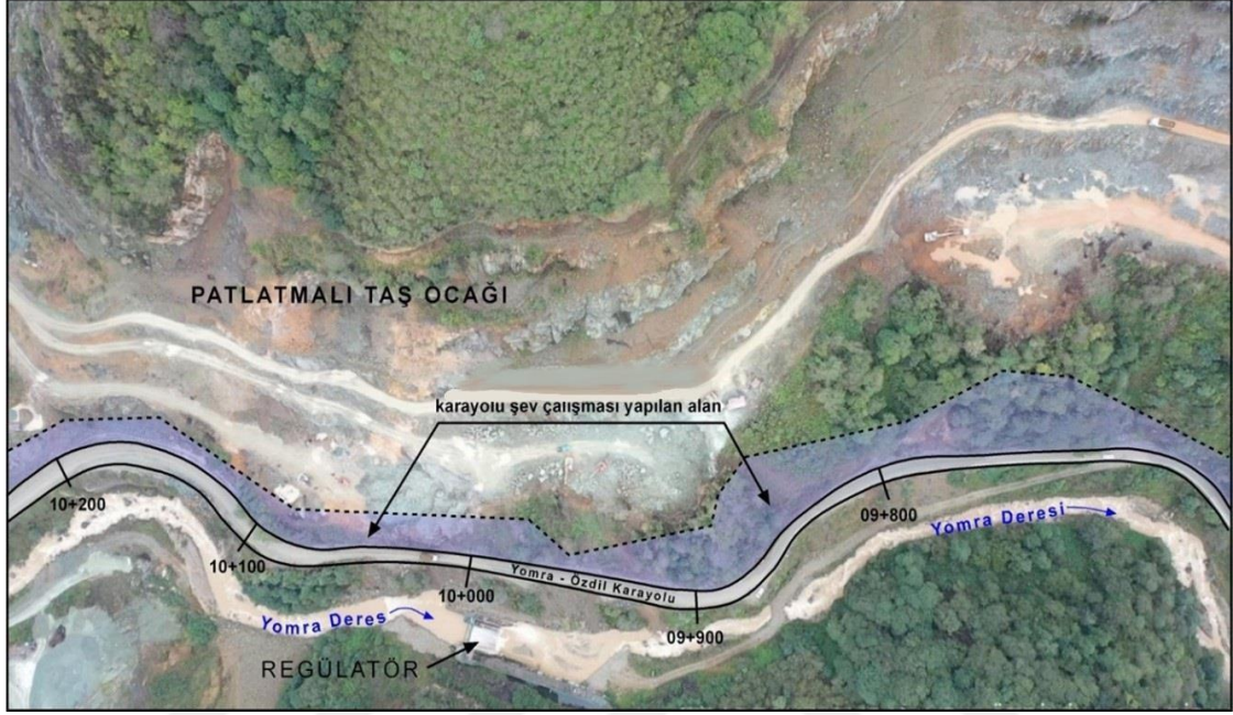
Şekil 3. Şev çalışması yapılacak alanda KM: 09+700 – 10+200 arasında kalan güzergah
