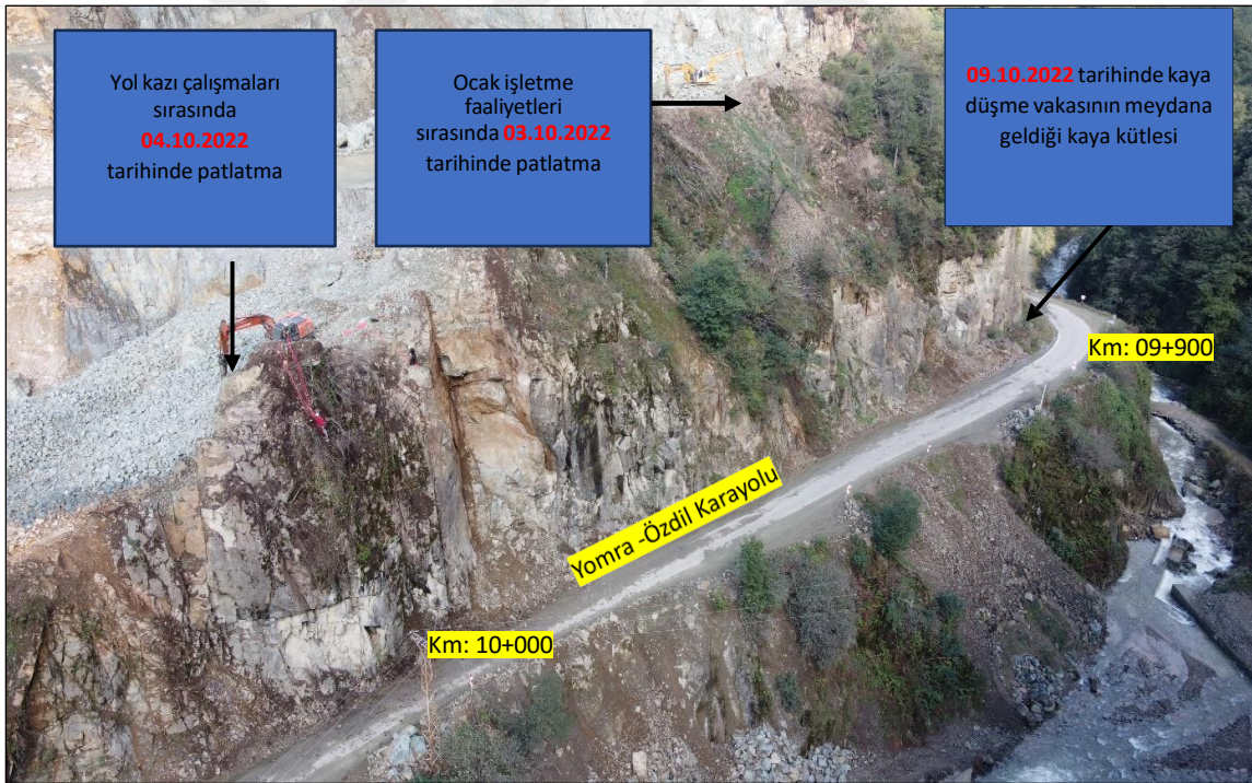
Şekil 36. 09.10.2022 tarihinde KM: 09+900'da süreksizlikler boyunca meydana gelen kama tipi yenilme sonrası kaya düşme vakasının yaşandığı alan ile patlatma yapılan alanlar arasındaki konumsal ilişki
