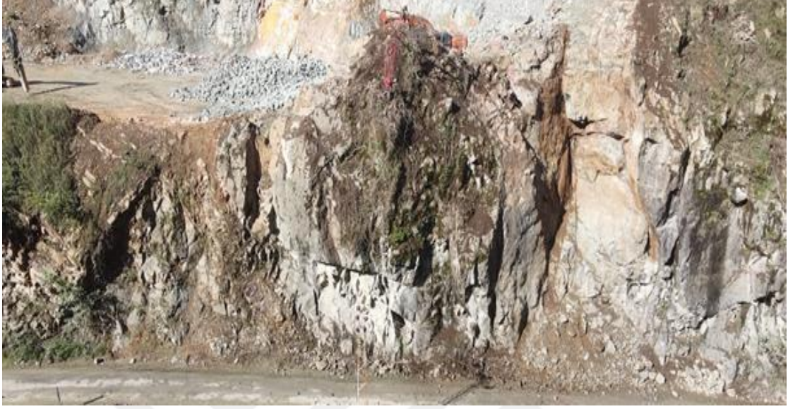
Şekil 6. KM: 09+900 – 10+100 arasında 2 farklı süreksizlik düzleminin ara kesiti boyunca meydana gelen kama tipi yenilme sonrası açığa çıkan süreksizlik yüzeyleri
