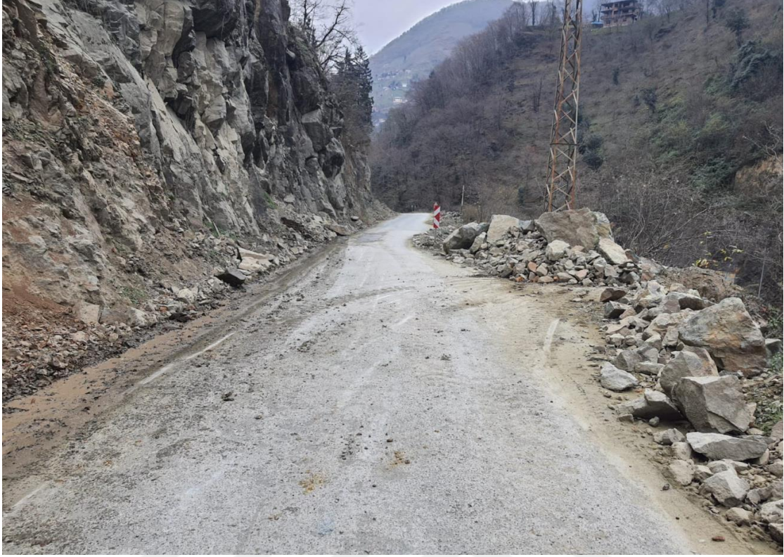
Şekil 42. Patlatmadan 5 dakika sonra karayolunun görünümü (5-10 cm çapında kaya blokları haricinde şevde yenilme ve kaya düşme olayı izlenmemiştir)
