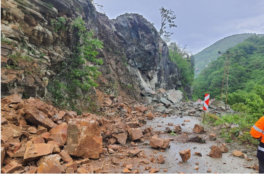
Şekil 46. Patlatmadan 15 dakika sonra karayolunun görünümü (Blokların çoğu şev temizliği ile düşürülen bloklardır)
