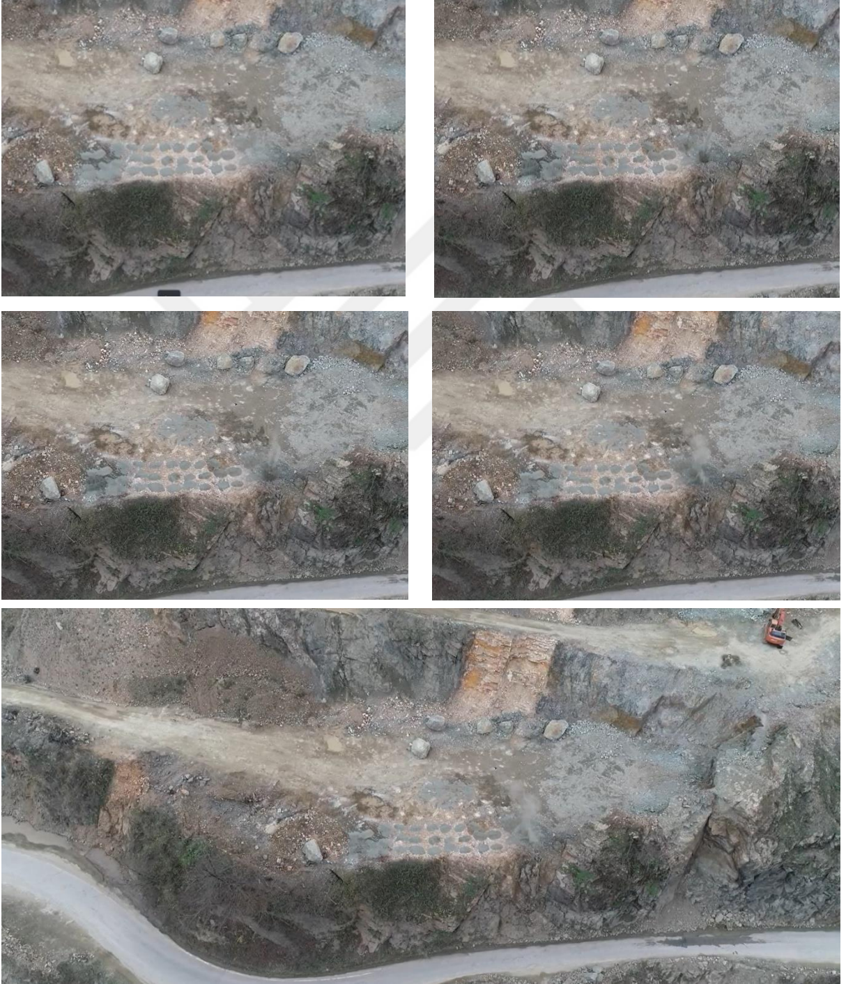
Şekil 41. Kaya kırıcı kartuş ile yapılan patlatmanın zamana bağlı görünümü (tüm fotoğraflar patlatma anından itibaren toplam 5 sn içerisinde alınmıştır)
