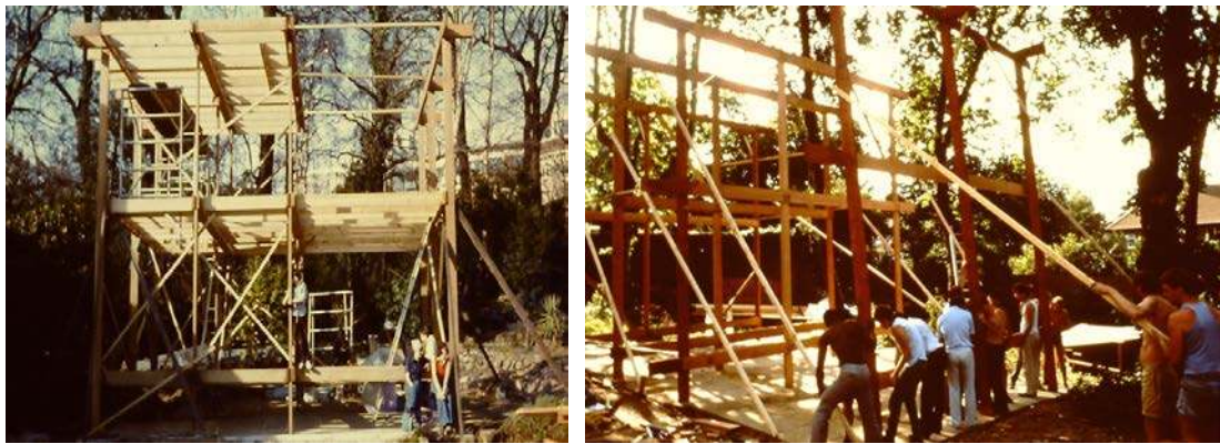
Şekil 56. Walters Way ve Segal Close inşa aşaması.
