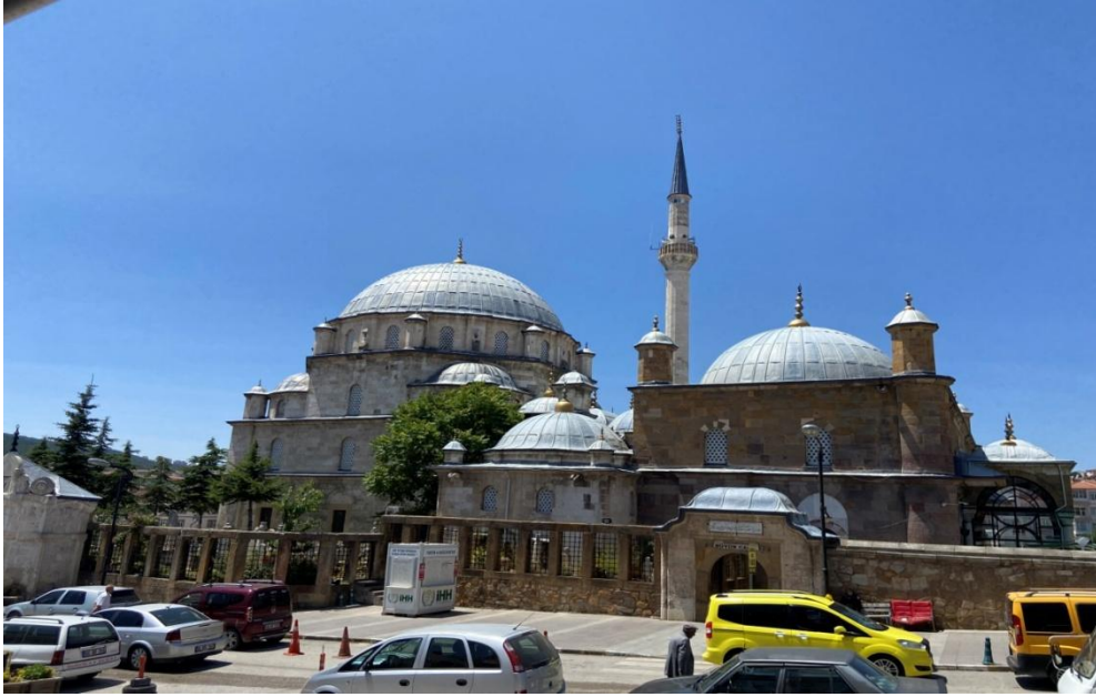
Foto 4.3. Çapanoğlu Camii Doğu Cephesi (Temmuz, 2023)
