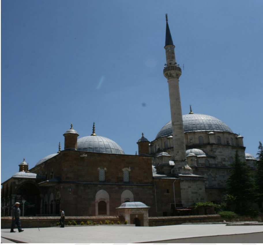
Foto 4.4. Çapanoğlu Camii Batı Cephesi (Temmuz, 2023)
