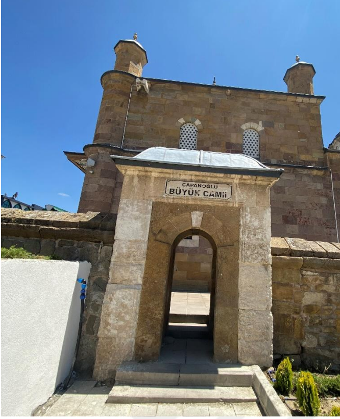
Foto 4.94. Çapanoğlu Camii Avlusunun Batı Giriş Kapısı (Temmuz, 2023)
