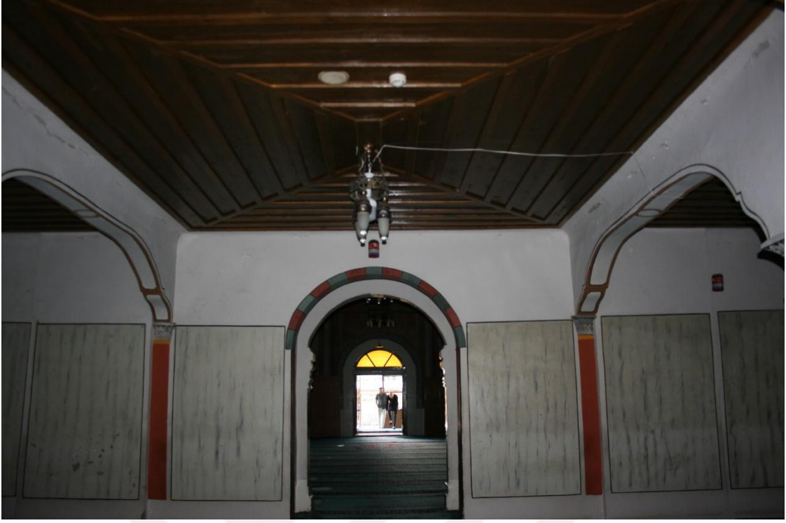
Foto 4.43. İ Cami Kuzeyde Mahfilin Alt Kısım Ortadaki Ahşap Tavanı ve Dış Camiye Çıkıştaki Orta Kemer Açıklığı (Temmuz, 2023)
