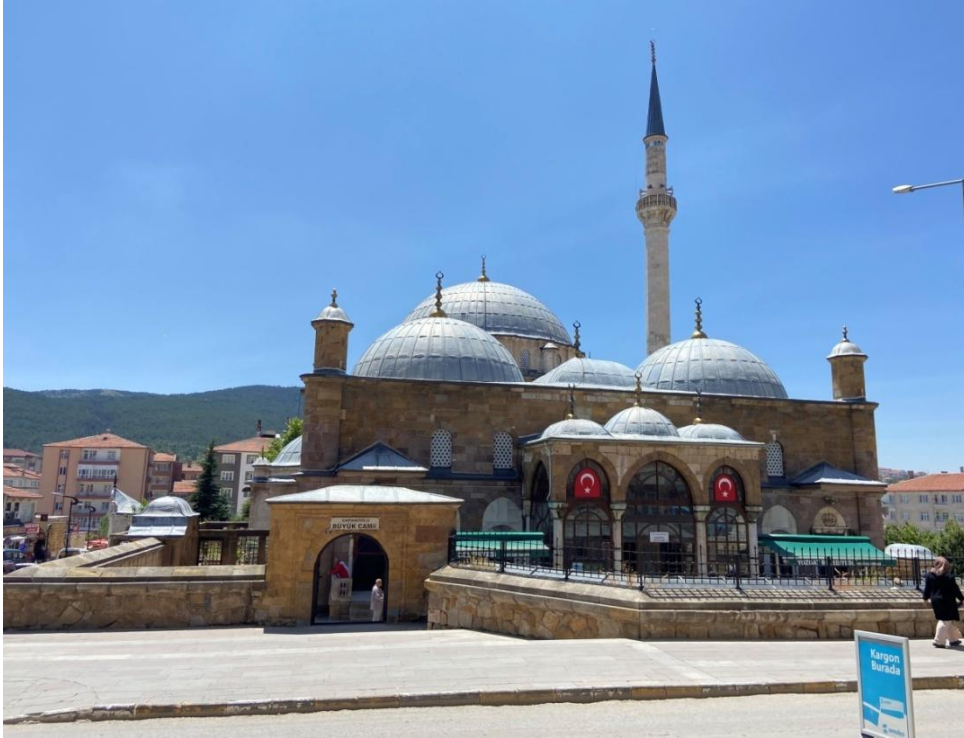
Foto 4.5. Çapanoğlu Camii Kuzey Cephesi (Temmuz, 2023)
