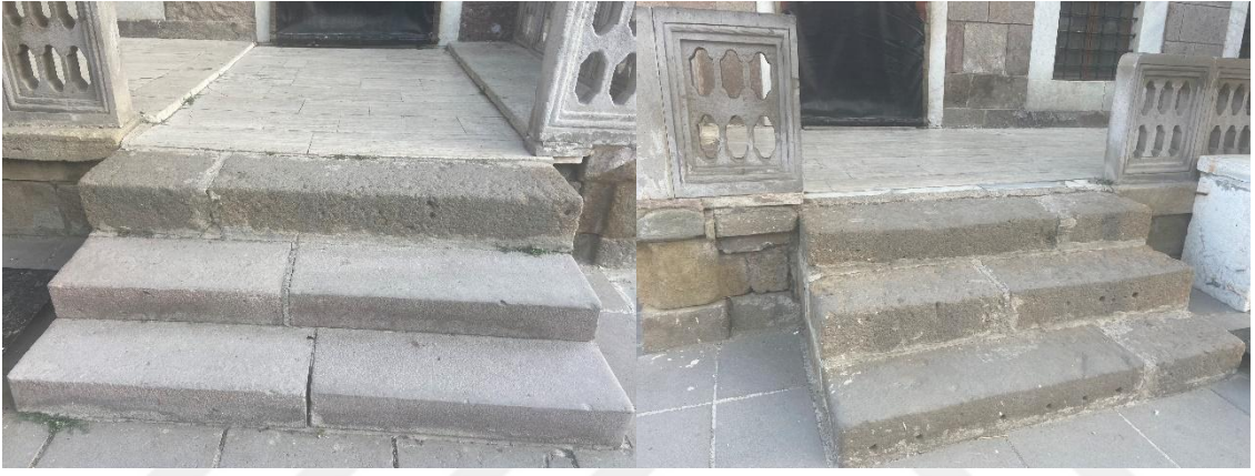
Foto 4.78. Caminin Doğu ve Batı Girişindeki Üçer Basamaklı Dikdörtgen Merdivenler (Temmuz, 2023)
