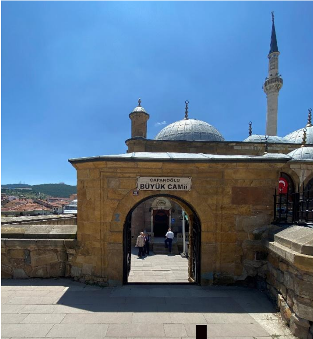
Foto 4.95. Çapanoğlu Camii Avlusunun Kuzey Giriş Kapısı (Temmuz, 2023)
