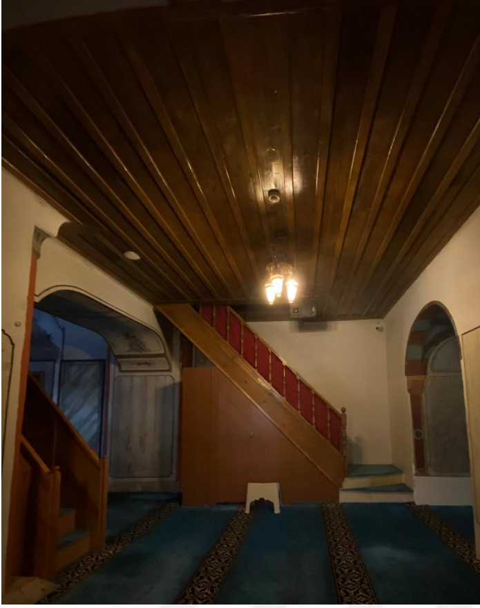
Foto 4.39. İ Cami Mahfile ıkılan Kuzeybatıda Yer Alan Merdivenler (Temmuz, 2023)
