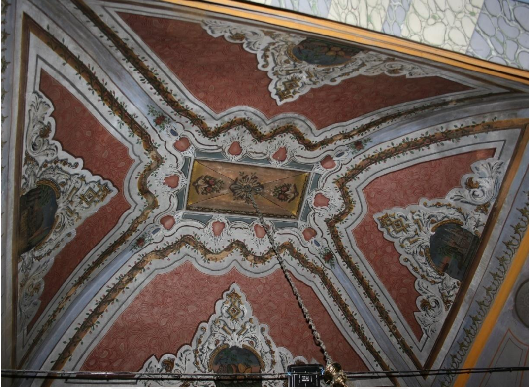
Foto 4.145. İ Cami Mahfil Katındaki TonoZ (Temmuz, 2023)
