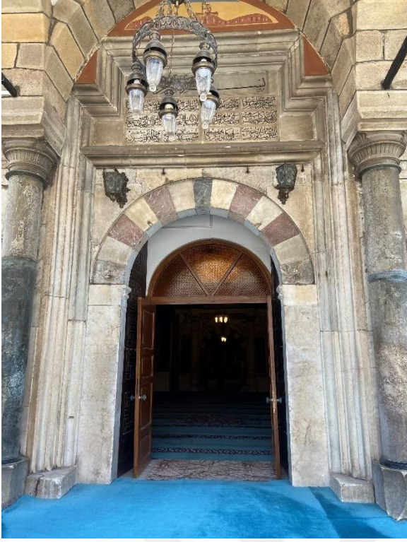
Foto 4.71. Caminin Mihrap Ekseninde Üzerinde Süleyman Bey'in Kitabesinin Yer Aldığı Orta Giriş Kapısı (Temmuz, 2023)
