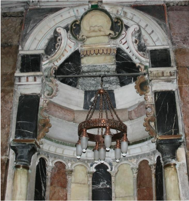
Foto 4.120. Çapanoğlu Camii Mihrap Kavsarası (Temmuz, 2023)
