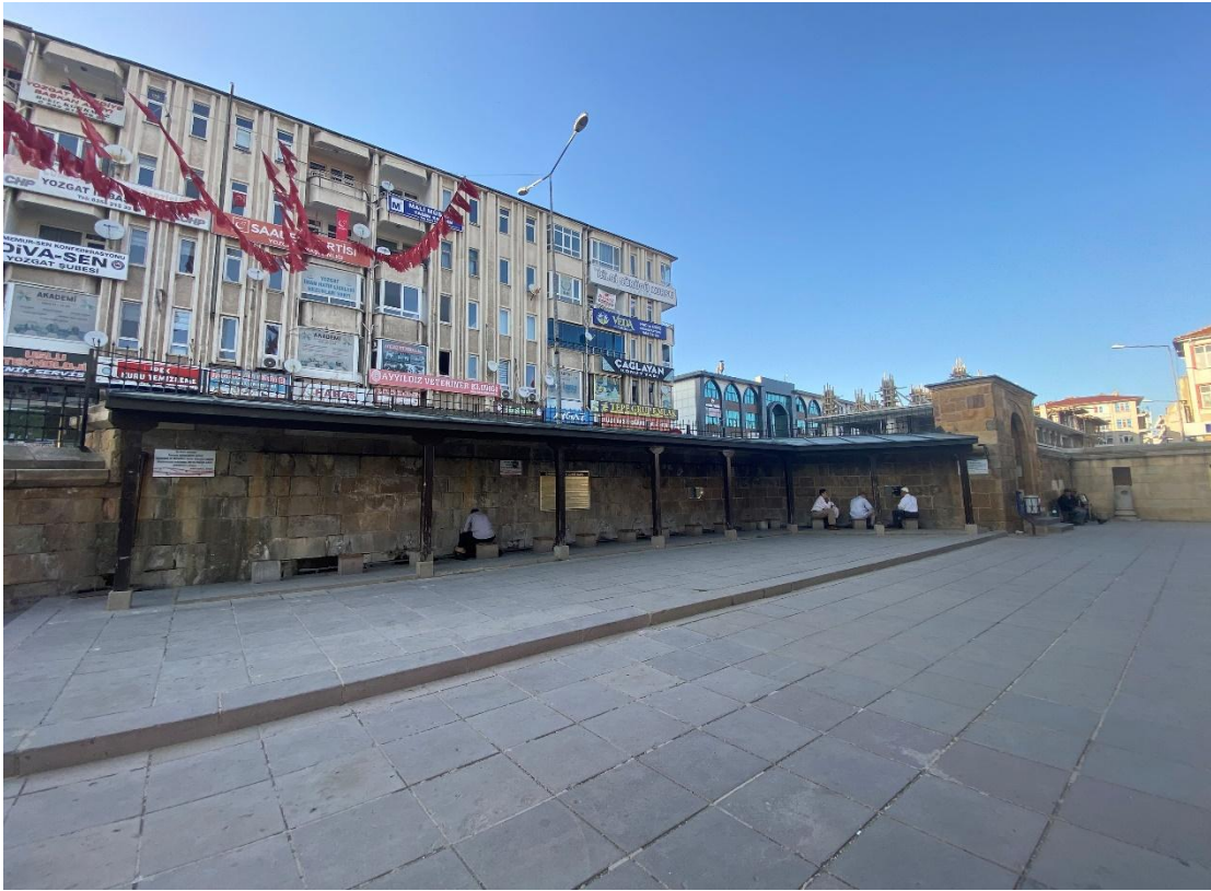
Foto 4.109. Çapanoğlu Camii Şadırvanı (Temmuz, 2023)
