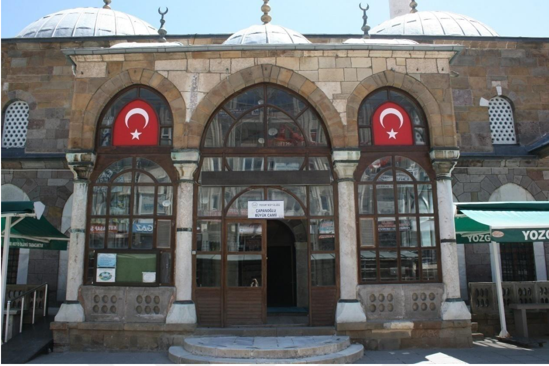
Foto 4.73. Caminin Önündeki Sekiz Sütunlu Sivri Kemerli Revaklı Yapı (Temmuz, 2023)
