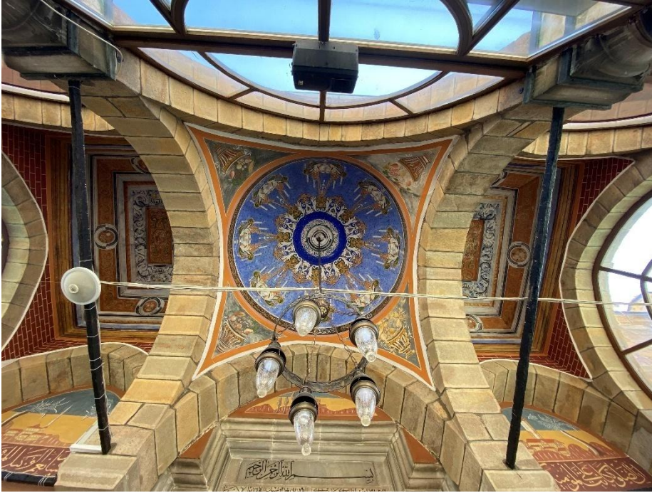
Foto 4.76. Caminin Önündeki Revaklı Yapının Ortasındaki Kubbe ve Aynalı Tonozlar (Temmuz, 2023)
