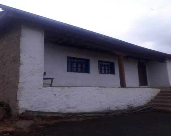
Resim 3.60. Odanın Kuzey Cephesi
