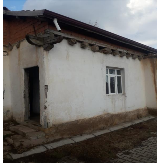
Resim 3.6. Odanın Güney Cephesi
