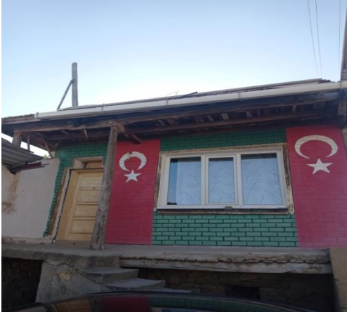
Resim 3.97. Odanın Batı Cephesi
