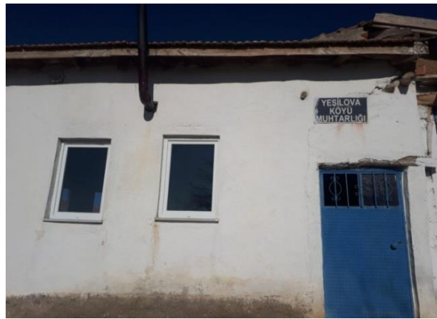
Resim 3.91. Odanın Batı Cephesi
