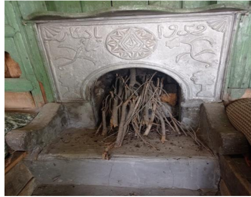
Resim 3.39. Odanın Ocaklık Kısım
