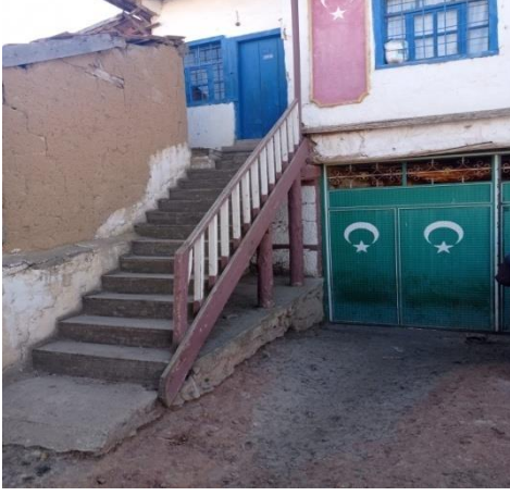
Resim 3.130. Odanın Batı Cephesi
