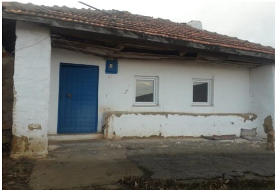
Resim 3.48. Odanın Batı Cephesi
