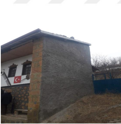
Resim 3. 142. Odanın Güneybatı Cephesi
