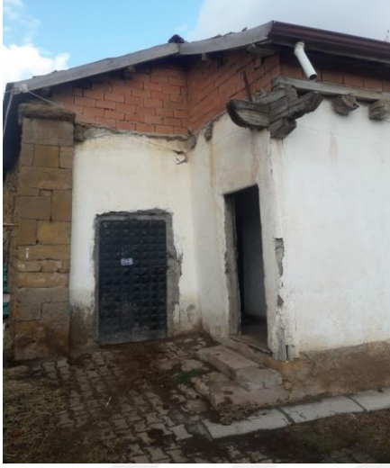
Resim 3.3. Odanın Güney Cephesi
