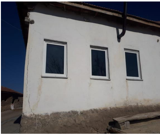
Resim 3.90. Odanın Güneybatı Cephesi
