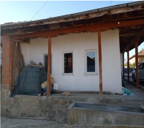
Resim3.70. Odanın Batı Cephesi
