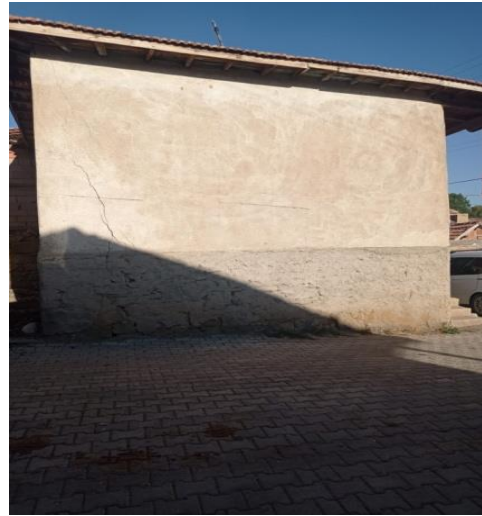
Resim3.112. Odanın Doğu Cephesi
