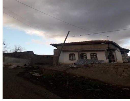
Resim 3.35. Odadaki Güney Cephesi
