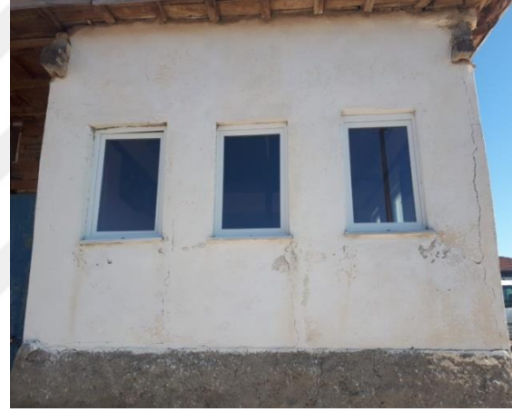
Resim 3.89. Odanın doğu Cephesi
