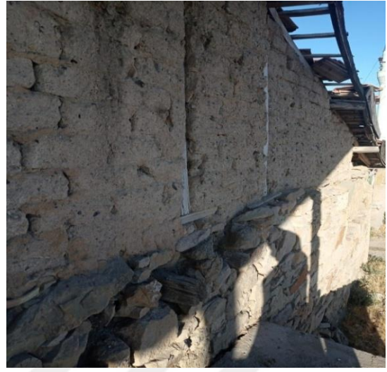
Resim 3.114. Oda'nın Kuzey Cephesi
