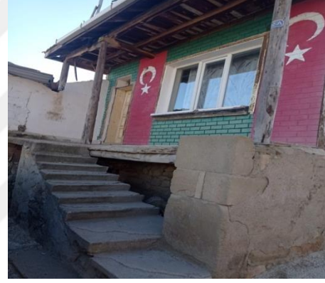
Resim 3.100. Odanın Batı Cephesi
