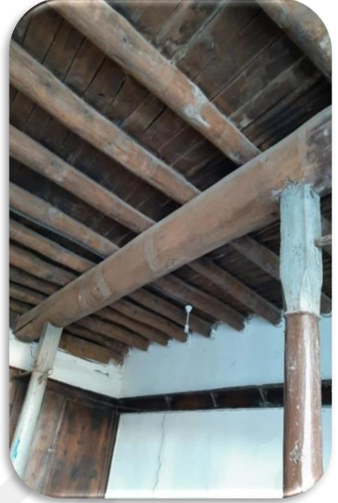
Resim 5.3. Karalar Köyü Şihî Kılıçaslan'ın Odasının kapısı ve Hezen denilen kirişleri tutmayı sağlayanküttük
