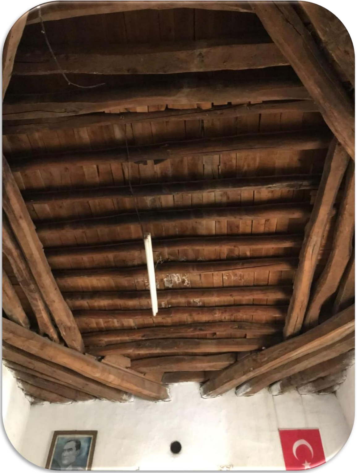
Resim 11.6. Paşaköy Köyü Rızvan Özcan'ın Odasının Kırlangıç stili kirişlemesi alttan tavan
