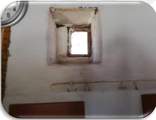
Resim 9.2. Paşaköy Hakkı'nın Oğlu Mehmed'in Odasının tepesinde yer alan soğutma penceresi ve kirişlemesi alttan tavan
