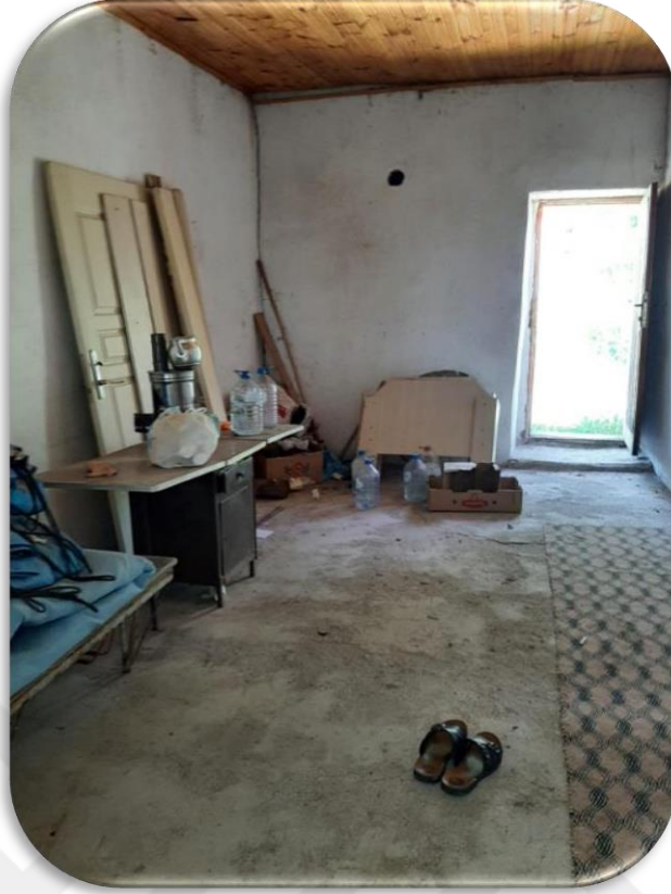
Resim 10.3. Paşaköy Hüseyin Onbaşının Odasının Aralığın içinden bir fotoğraf. Karşıdaki kapı ise odanın bahçesine açılan kapı
