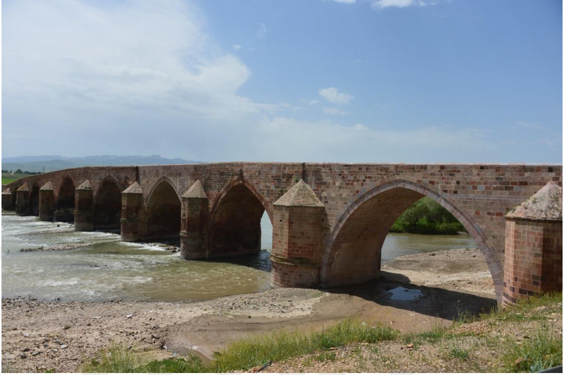
Şekil 4.21. Çobandere Köprüsü'nden görünüm (Orijinal)
