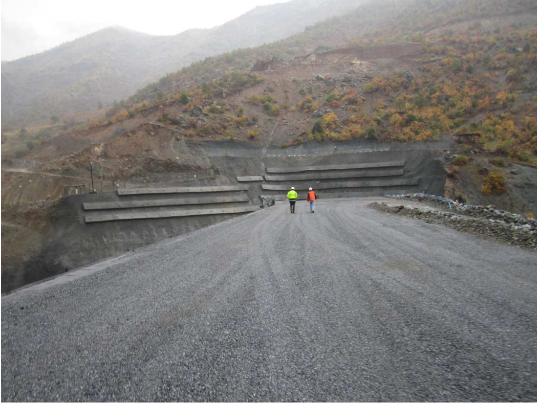
Şekil 5.5 : Sol sahildeki tamamlanan  ngermeli ankraj uygulaması.
