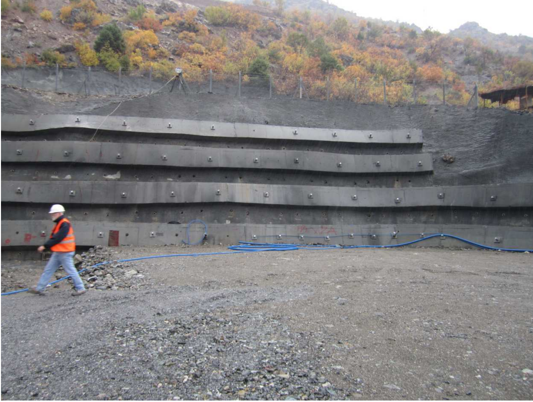
Şekil 5.6 : Sol sahilde tamamlanan öngermeli ankraj uygulaması.
