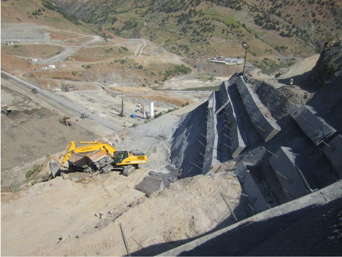
Şekil 5.3 : Şev yüzeyine uygulanan kademeli ankrajlar.
