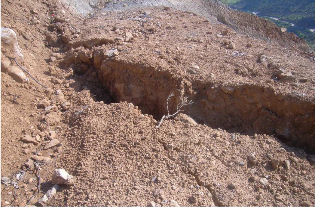
Şekil 4.3 : Sol yakada hareketli yamaç molozu bloğunun içinde izlenen çatlaklar.
