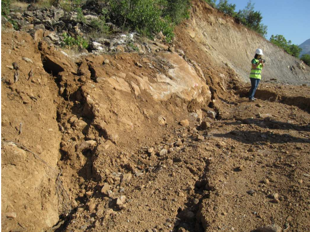
Şekil 4.4 : Sol yakada gözlenen heyelan taş bölgesi çatlakları ve heyelan aynası.
