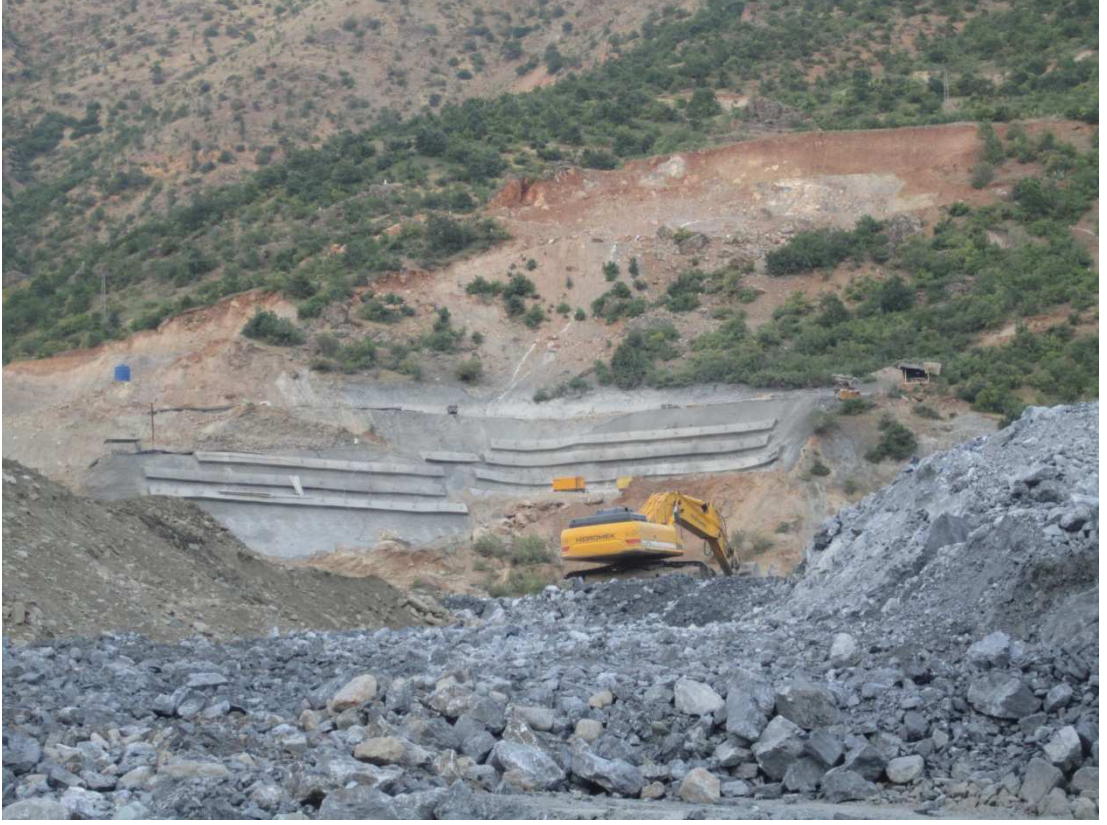
Şekil 5.4 : G vde dolgusu ile beraber devam eden ankraj uygulaması.
