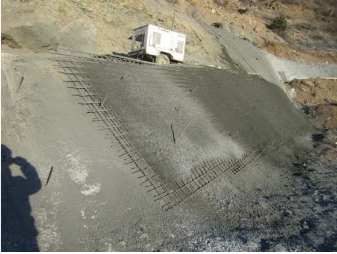
Şekil 5.2 : Çelik hasır ve püskürtme betonu uygulaması.
