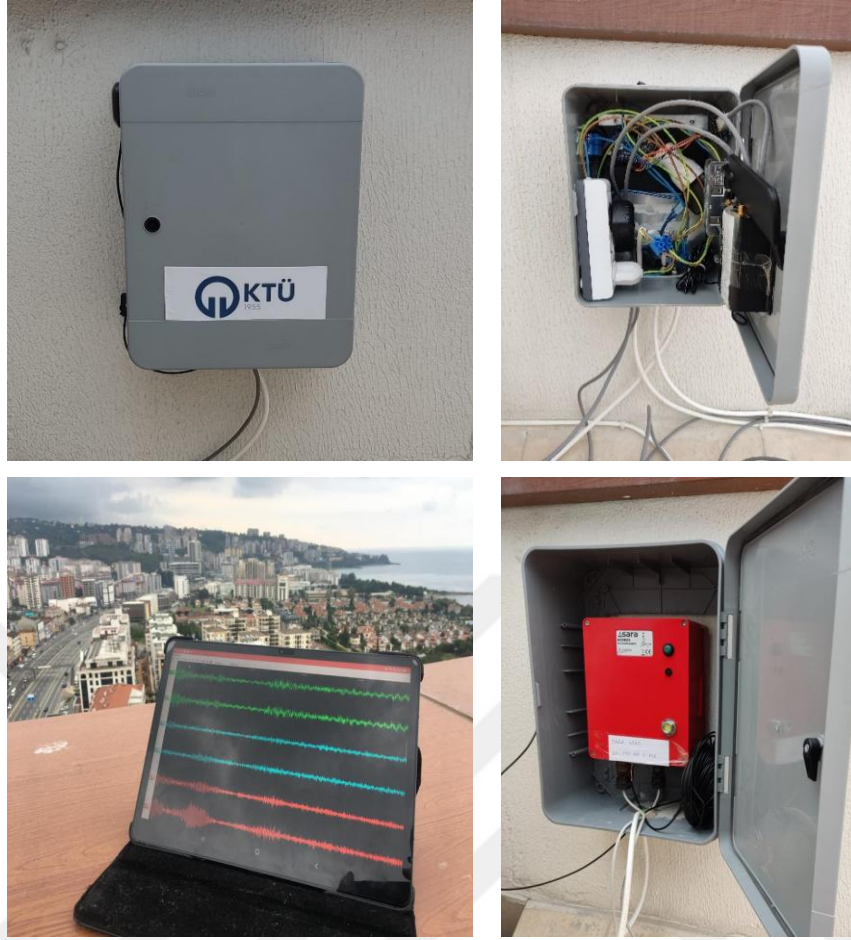
Şekil 23. 23 katlı binanın deneysel ölçümlerine ait bazı fotoğraflar
