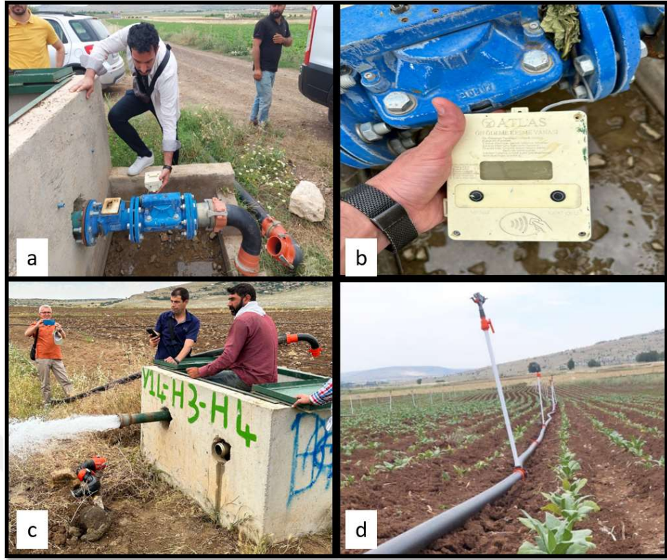
Şekil 3.3. Saha ziyaretleri a) Hidrant kontrol birimi; b) Ön ödemeli sayaç; c) Tarla başında bulunan hidrantlar; d) Yağmurlama sulama sistemi
