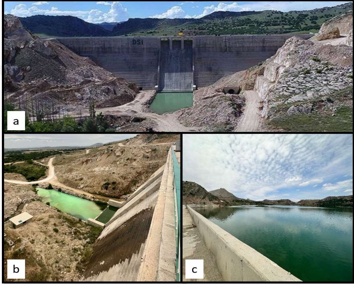
Şekil 3.2. Ergani Barajı a) Baraj gövdesi; b) Mansap; c) Memba
