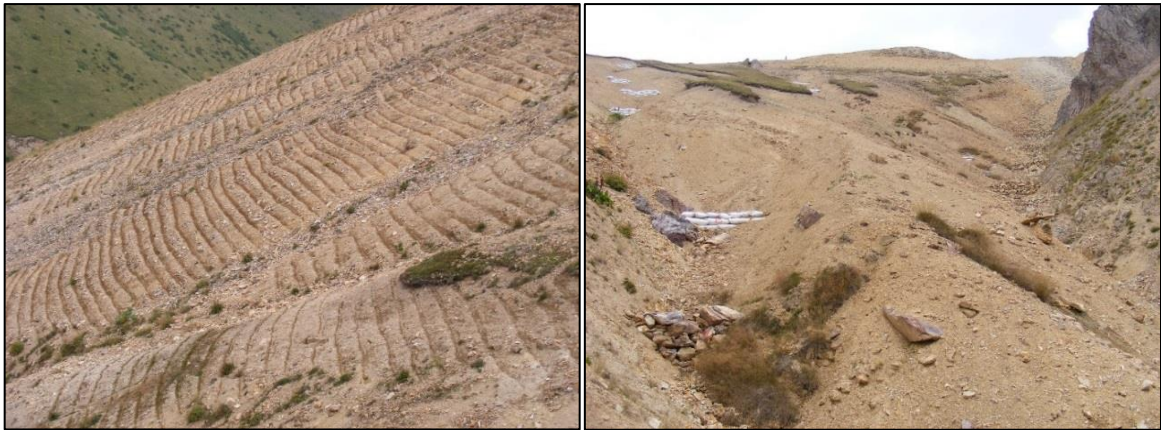
Şekil 4. Erozyon tehlikesine karşı yamaçta eşyükselti eğrilerine paralel olarak yapılmış arazi hazırlığı ve oyuntu erozyonu tehlikesine karşı yapılmış olan kuru duvar eşikler ve çuvalı setler (Trabzon, Tonya)
