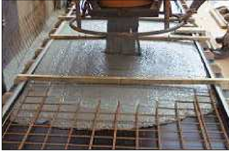
Resim 2.4 Almanya'dan KYB uygulaması, prekast duvar elemanı (Gürdal ve Yüceer 2004)
