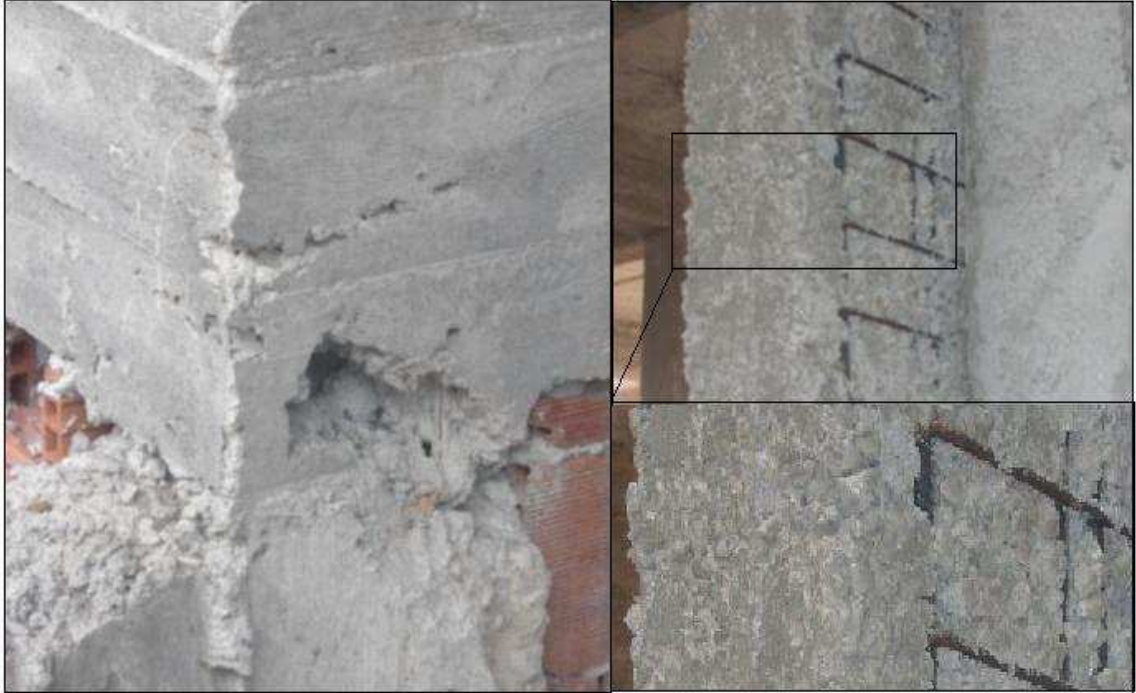
Resim 1.1 Kolon ve kirişlerde yapısal kusurlar; Ankara'dan bir örnek
