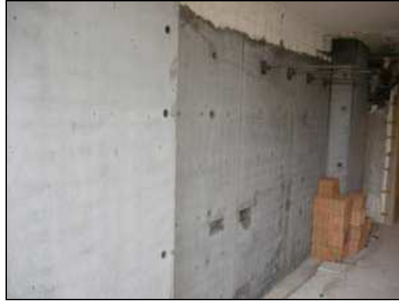
Resim 2.7 Türkiye’den KYB uygulaması, otel binası güçlendirilmesi (Gürdal and Yüceer 2004)
