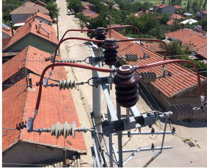
Şekil 3-6: İzolatör Pimleri Yükseltilmiş Giydirme ve Sıkı Bağ Çalışması
