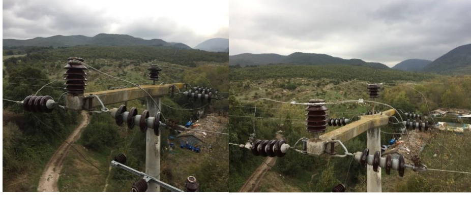
Şekil 3-12: Pim Yükseltme Çalışması ve Atlamaların Yenilenmesi
