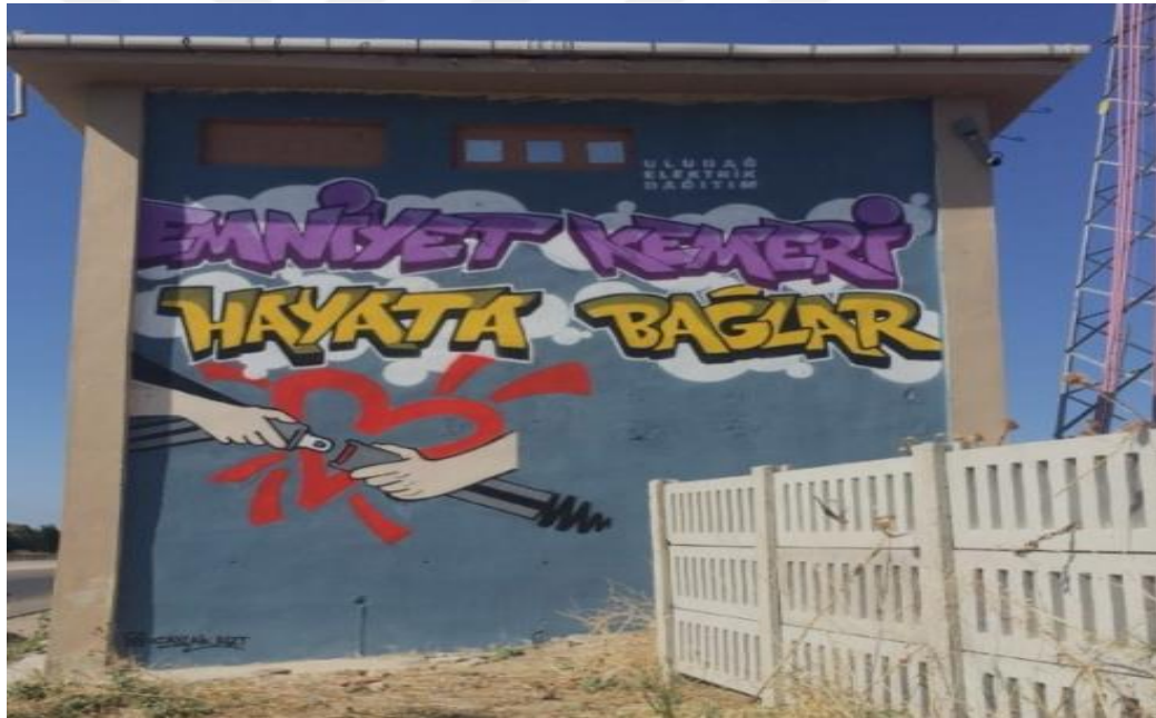
Şekil 5-1: Akçapınar KÖK ve Sosyal Sorumluluk Projesi Kapsamında KÖK Binası Üzerine İşlenen Resim
