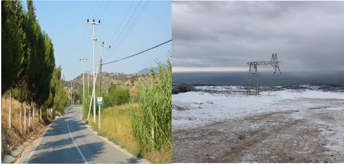
Şekil 3-10: Hava Şartları Sebebiyle Eğilen ve Kırılan Direkler
