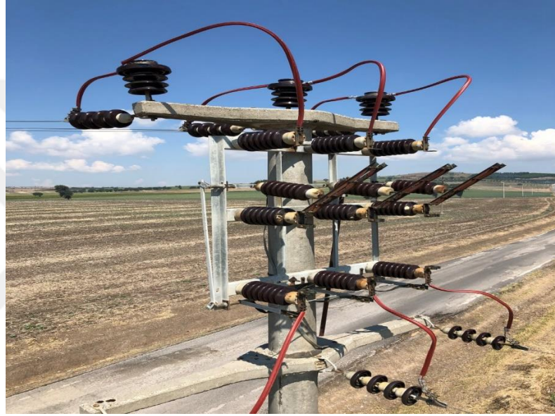
Şekil 3-3: Atlamalara YG giydirme yapılmış sıkı bağ yenilenmiş bir HSTA
