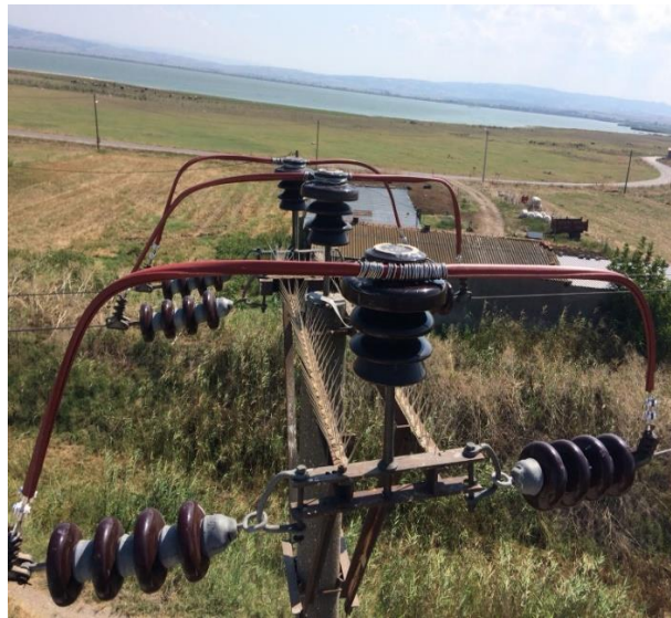
Şekil 3-9: Manyas Gölü Bölgesinde Kuş Çarpmalarına Karşı Yapılan Çalışma
