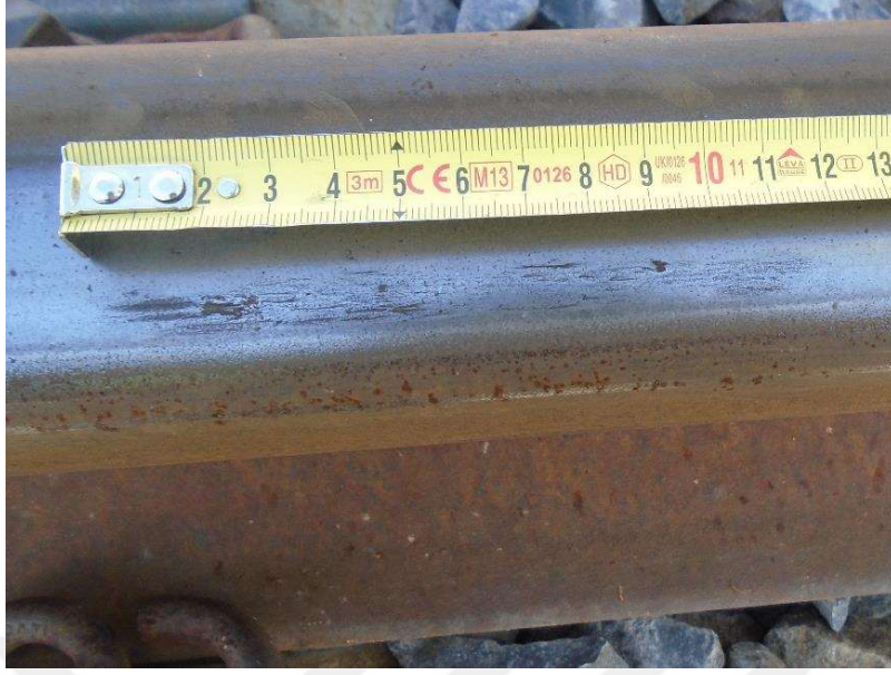
Görsel 3.4. Ray yüzeyindeki çizilmeler
