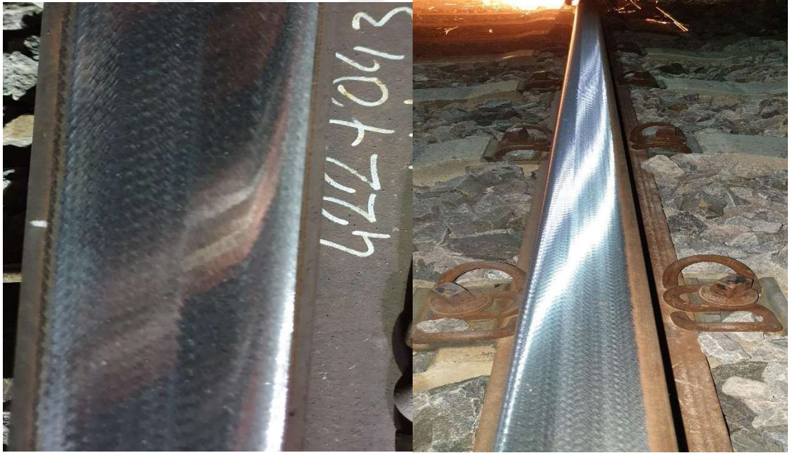
Görsel 3.10. Taşlama sonrası mikro oyuklar ve pullanma kusuru giderilmiş
