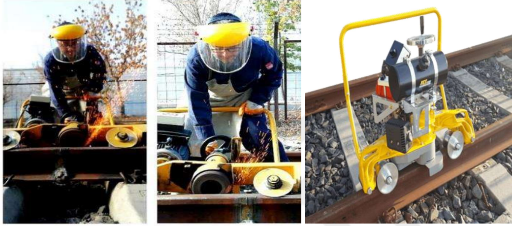
Görsel 1.5. Ray profil taşlama işlemi
