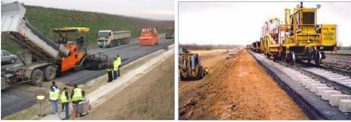
Resim 2.5 İtalya yüksek hızlı demiryolu hattına BSK kaplama tabakasının serilmesi (Rose et al. 2015).
