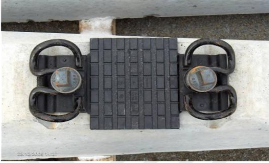
Resim 2.2 Travers bağlantı elemanları.
