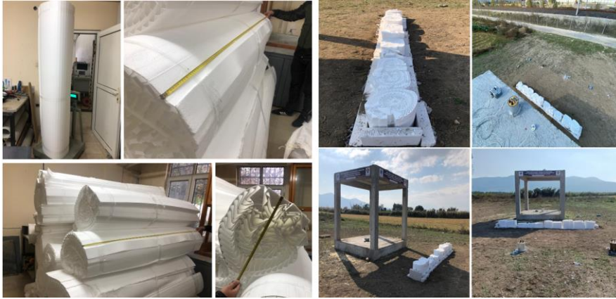
Şekil 3.18. Gaz beton cidarlı açık hendek tipi dalga bariyerinin inşaatı.
