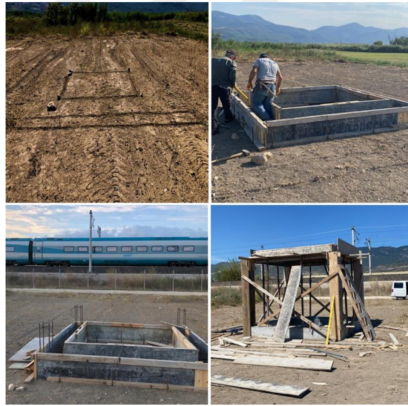
Şekil 3.40. Bina yapım süreci.
