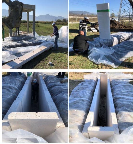
Şekil 3.17. Gaz beton cidarlı açık hendek tipi dalga bariyerinin inşaatı.
