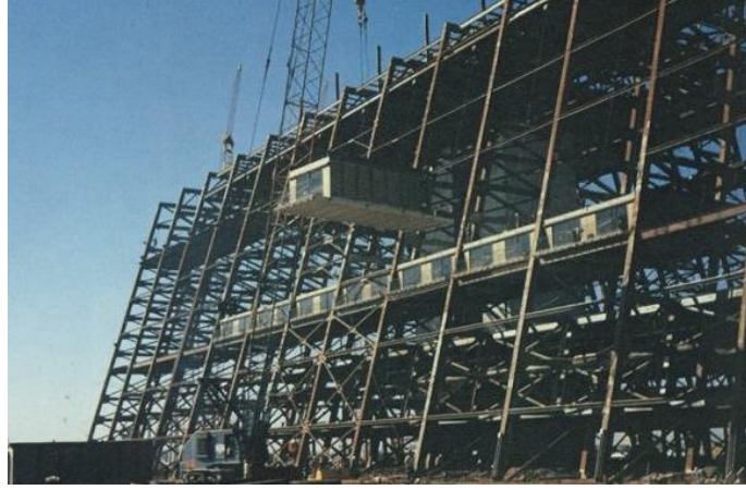
Şekil 1.19. Disneyland’da bulunan tatil otelinin yapım aşaması (Anonymous 2021)
