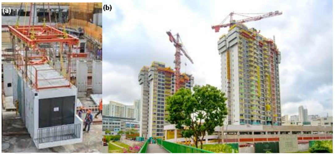
Şekil 1.22. Clement Canopy Tower (a) 3D modül (b) yapım aşaması (Anonymous 2019c).
