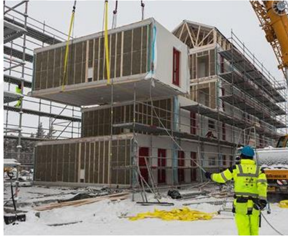
Şekil 1.12. Modüllerin sahada montajı (Anonymous 2022i)
