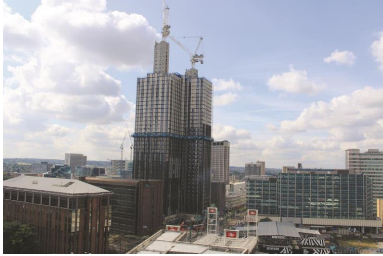
Şekil 1.23. Croydon Tower'ın yapım aşaması (Anonymous 2019d)
