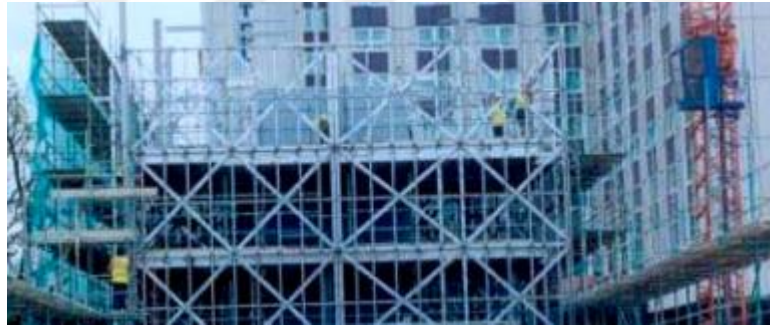
Şekil 1.20. Çelik çapraz destekli modüler sistem (Lawson and Ogden 2005)
