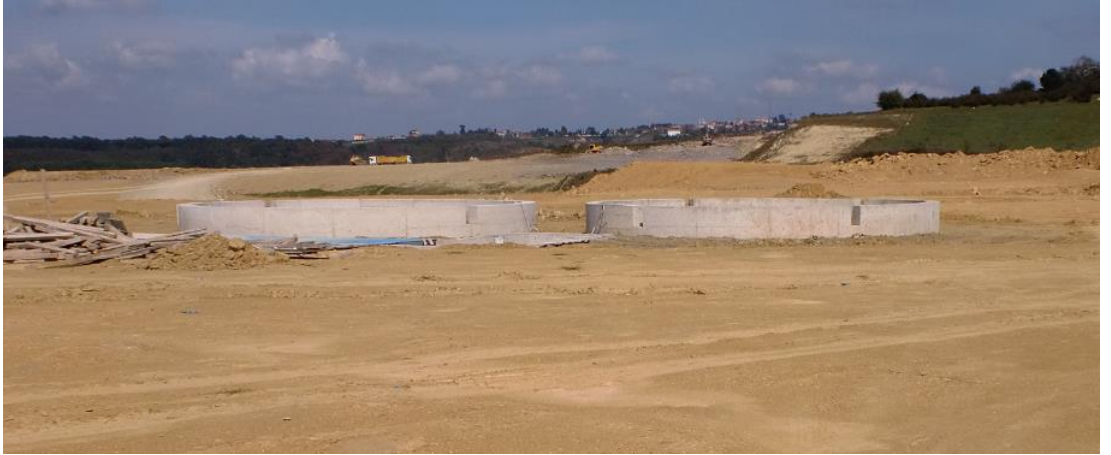
Şekil 2.2. Mevcut silo temeli altında zemin iyileştirmesi [3]
