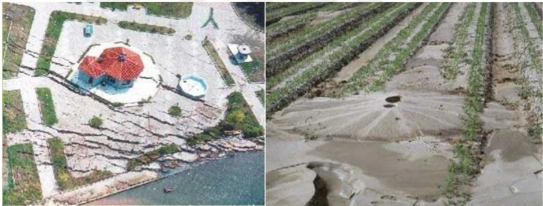
Şekil 2.3. Sıvılaşma problemine örnekler [4]
