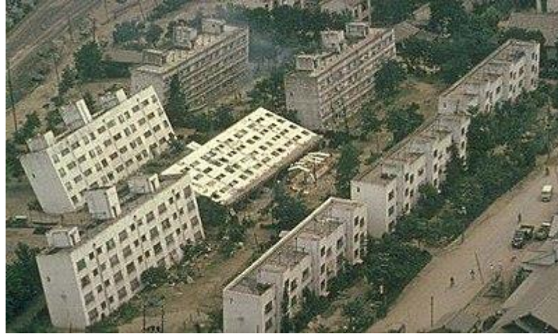
Şekil 2.4. 1964 Niigata (Japonya) depreminde zemin sıvılaşması [5]
