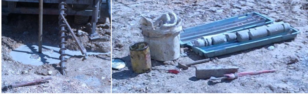
Şekil 3.17. Jet Grout kolonlarından alınmış karot numune alma
