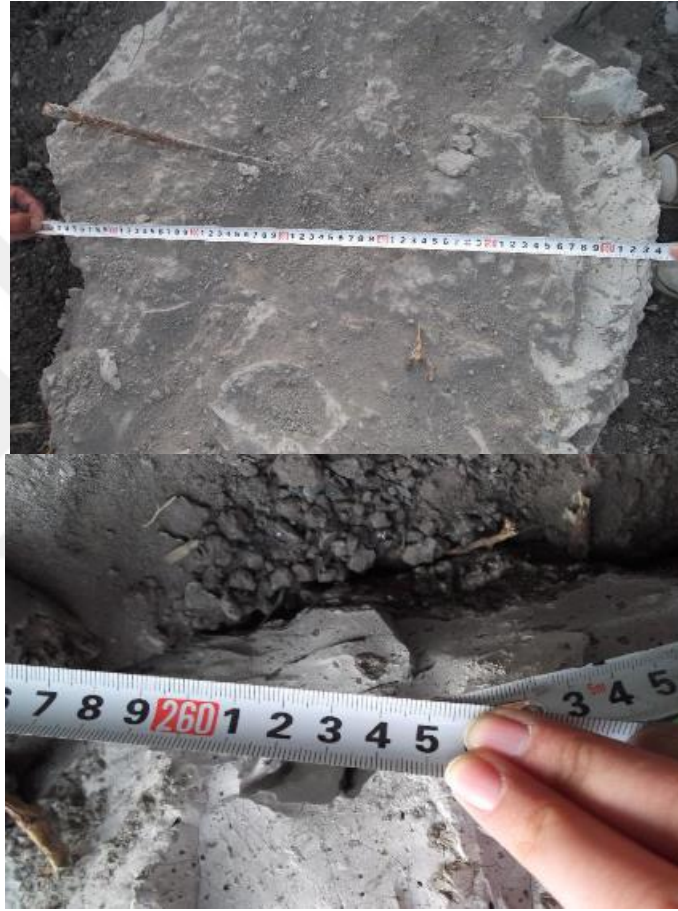
Şekil 3.16. Jet Grout deneme kolonu çap kontrolü (Çınar, 2014).
