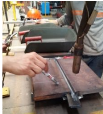
Şekil 5.13. Pasolar arası geçiş sıcaklığının ölçümü.
