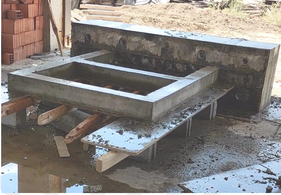
Şekil 3.22. Betonarme çerçevelerin kalıplarının çıkartılması
