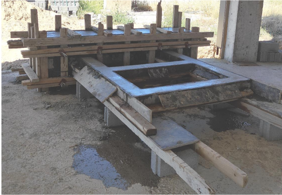
Şekil 3.21. Betonarme çerçevelerin sulanarak kür uygulanması
