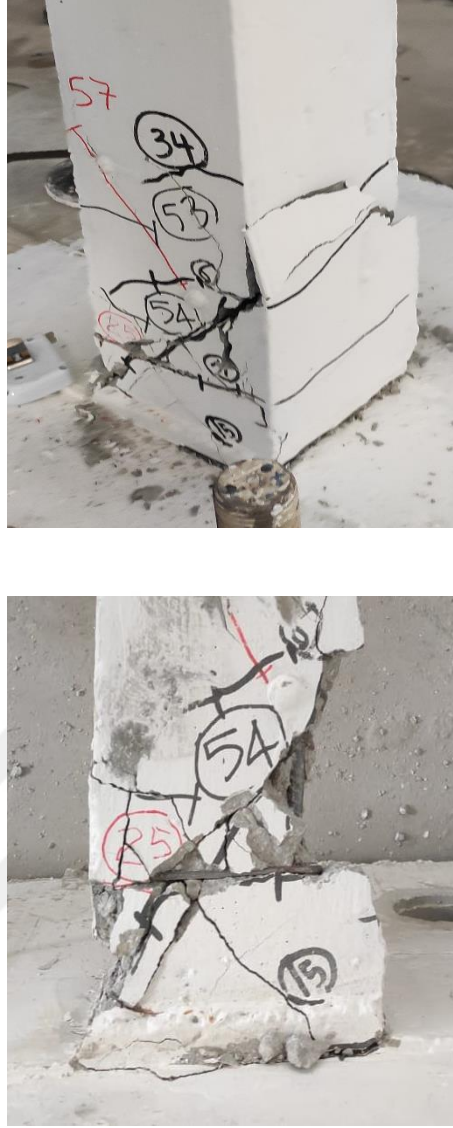
Şekil 4.10. S101 kolonunda deney sonunda oluşan hasarlar
