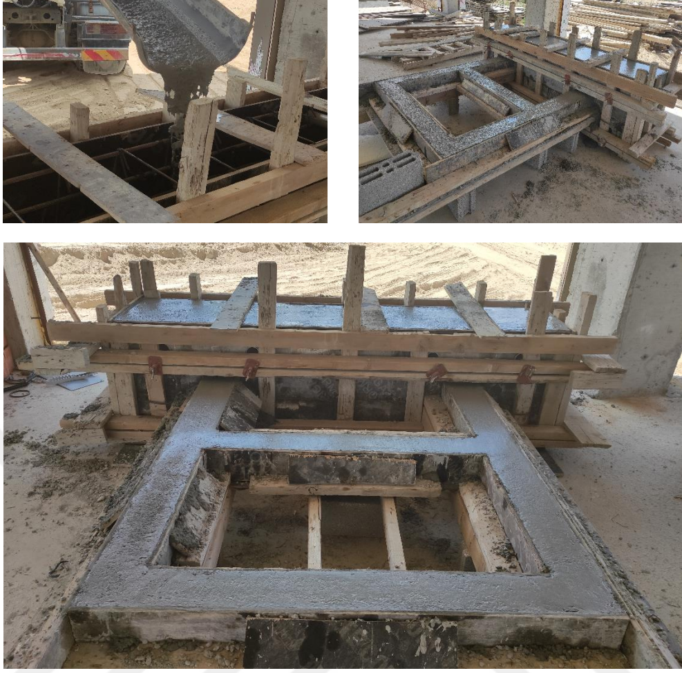
Şekil 3.20. Çerçeve numunelerinin betonunun dökülmesi
