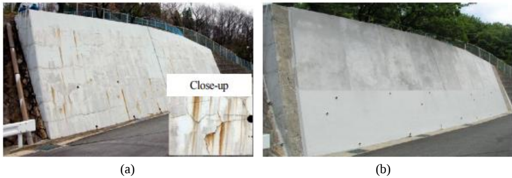
Şekil 1.7. (a) İstinat duvarının yüzeyinin onarımdan önceki görünümü (b) Onarımdan sonraki görünümü (Rokugo ve ark., 2005)
