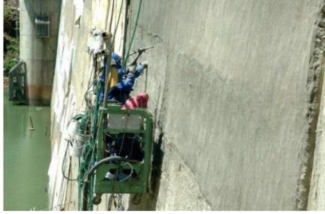
Şekil 1.6. ECC'nin Mitaka Barajına püskürtme yöntemiyle uygulanması (Kojima ve ark., 2004)
