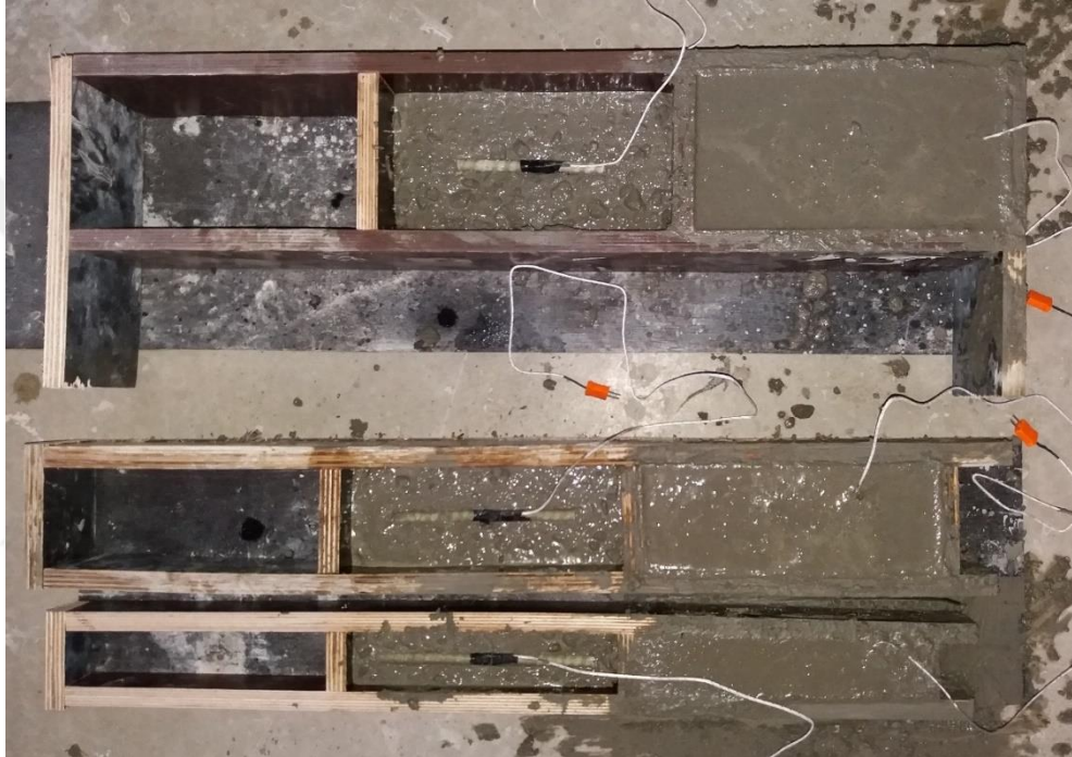
Şekil 4.14. Beton döküm aşaması
