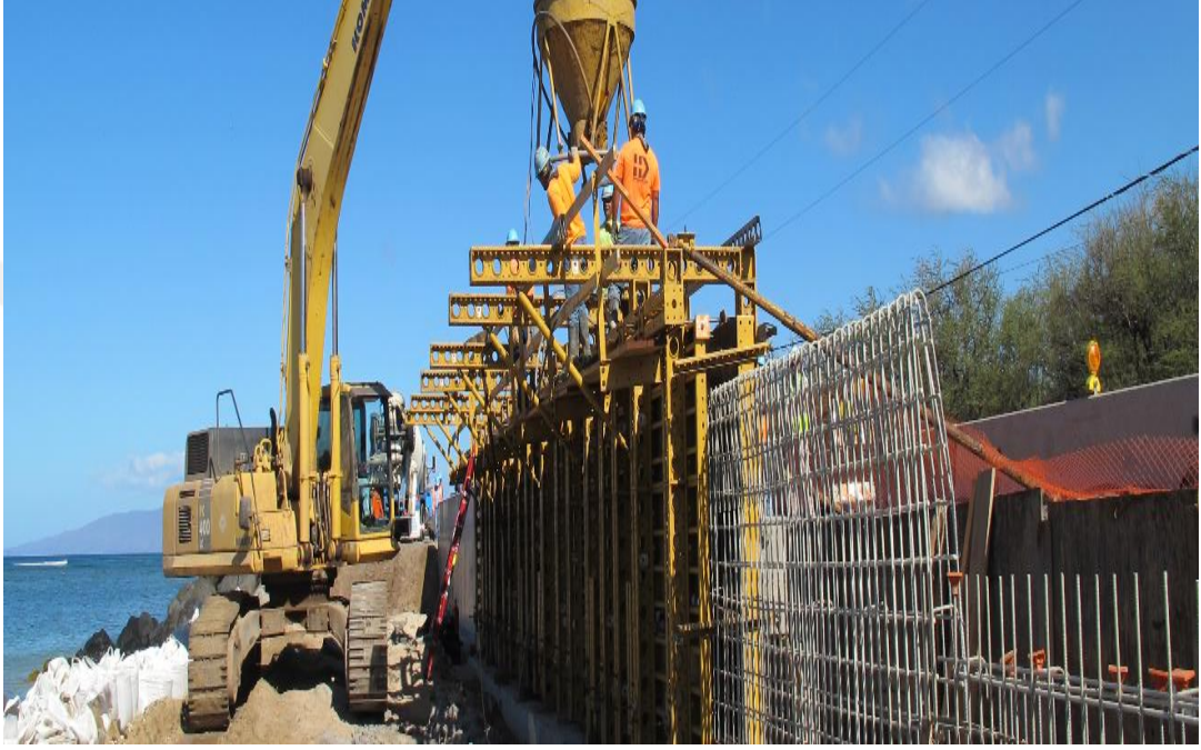
Şekil 2.9. Deniz yakını yapılarda FRP kullanım örnekleri [92]
