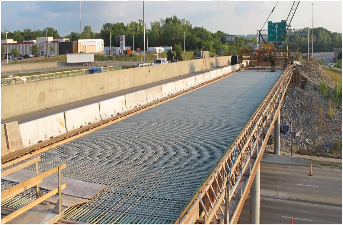
Şekil 2.10. Köprü yapımında FRP donatı kullanımı [92]
