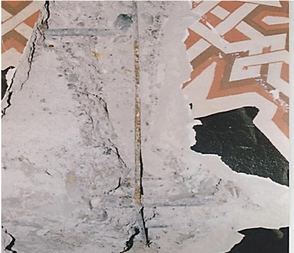
Şekil 2. 2.Donatı sıyrılması (düz donatı).
