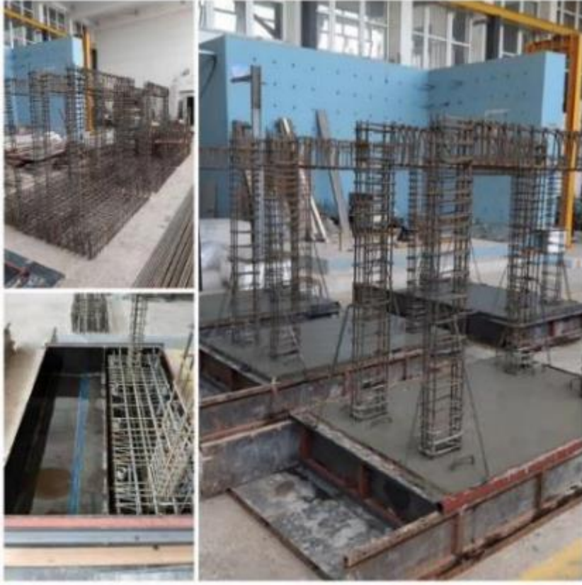
Şekil 13. Deney elemanlarının temel betonunun dökülmesi
