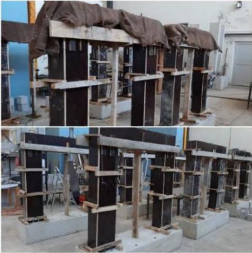
Şekil 14. Deney elemanlarının kolon ve kiriş betonlarının dökülmesi
