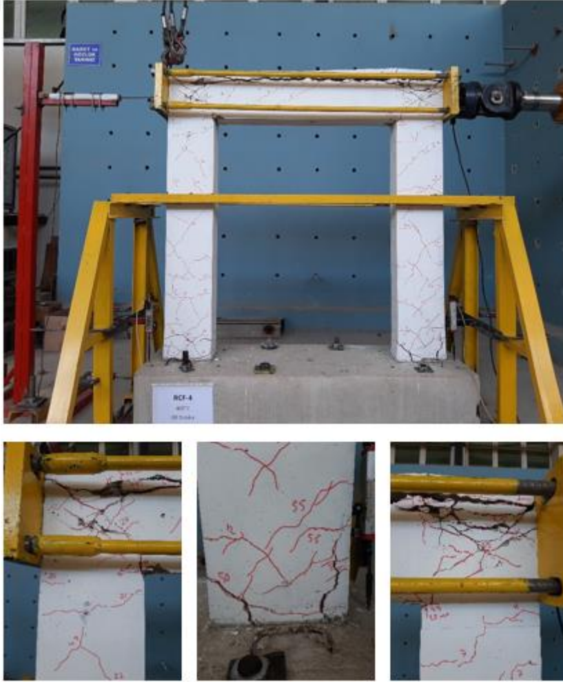
Şekil 53. Deney sonu RCF_4_400_60 deney elemanında oluşan hasar durumları
