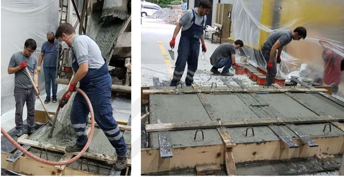
Şekil 2.6. Kemer modellerin temel beton dökümü
