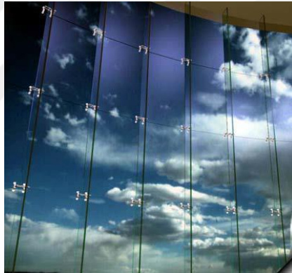
Şekil 5.27. Transparan Cephe (MEB,2012)
