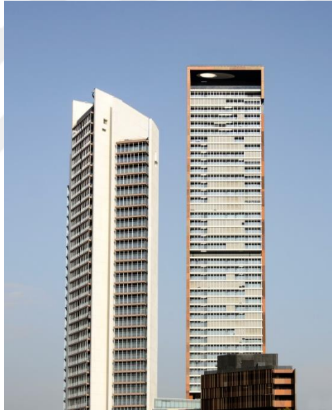
Şekil 6.28. Ege Perla Ofis Kulesi Cephe Kaplamaları(URL61)
