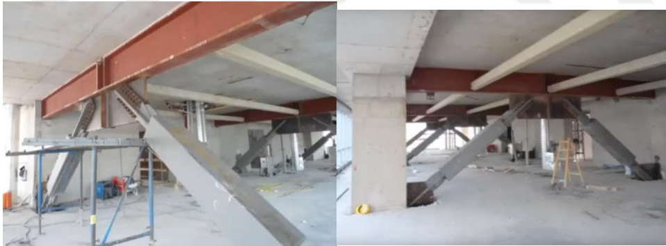
Şekil 6.19. Folkart Towers Outrigger Sistem (URL55)
