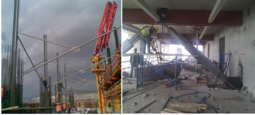
Şekil 6.20. Folkart Towers Kompozit Kolonlar ve Outrigger Sistem (URL55)
