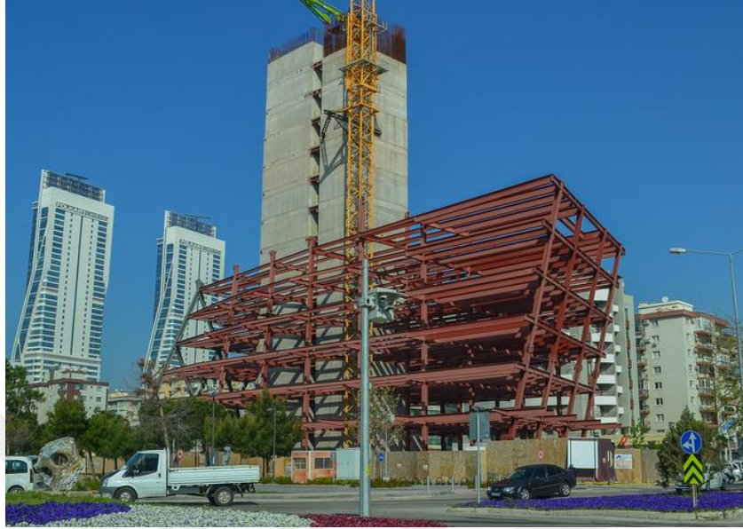
Şekil 6.31. Biva Tower Çelik sistem (URL-63)
