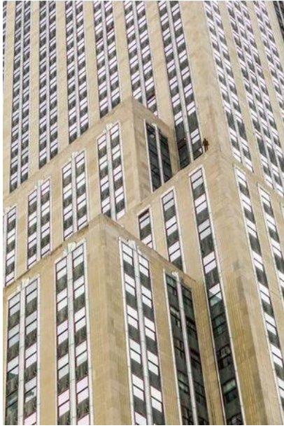
Şekil 3.8. Empire State Building (URL-7)
