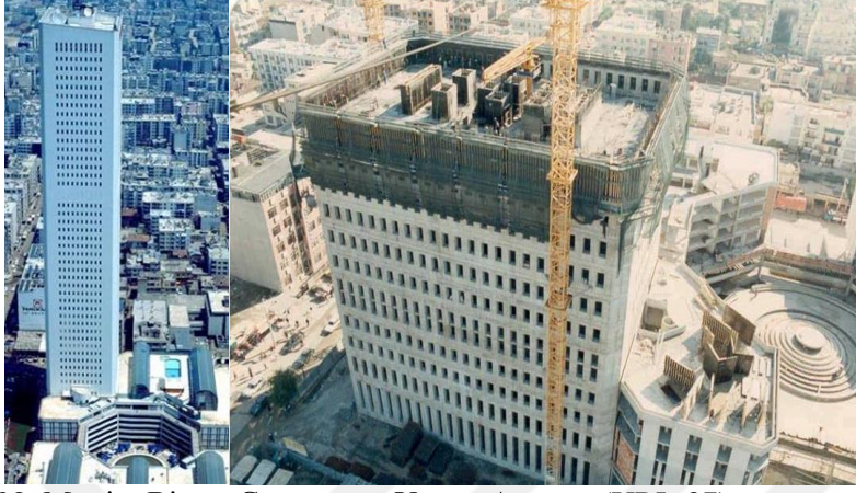
Şekil 4.28. Mertim Binası Görünüş ve Yapım Aşaması(URL-27)
