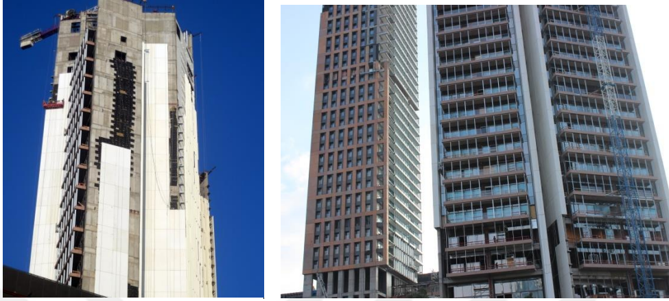
Şekil 6.27. Ege Perla Ofis Kulesi Cephe Kaplamaları(URL60)
