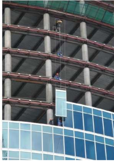
Şekil 5.25. Panel Montajı (Gülbağ A. B., 2012)
