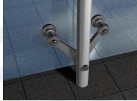
Şekil 5.29. Transparan cephe sisteminde kullanılan iki yönlü ve dört yönlü bağlantı elemanı (MEB, 2012)
