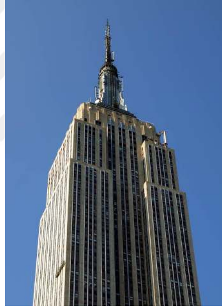
Şekil 3.9. Empire State Building (URL-8)
