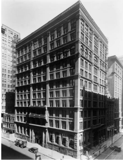
Şekil 3.1. Home I. Binası(URL-1)
