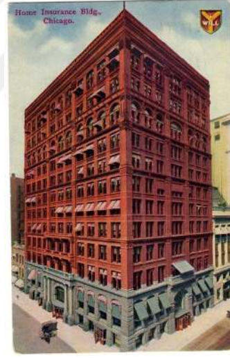
Şekil 3.2. Home I. Binası(URL-2)
