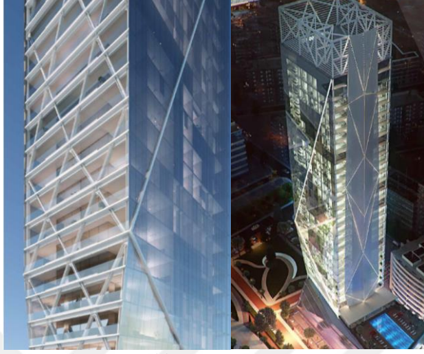
Şekil 6.34. Biva Tower Cephe (URL-66)
