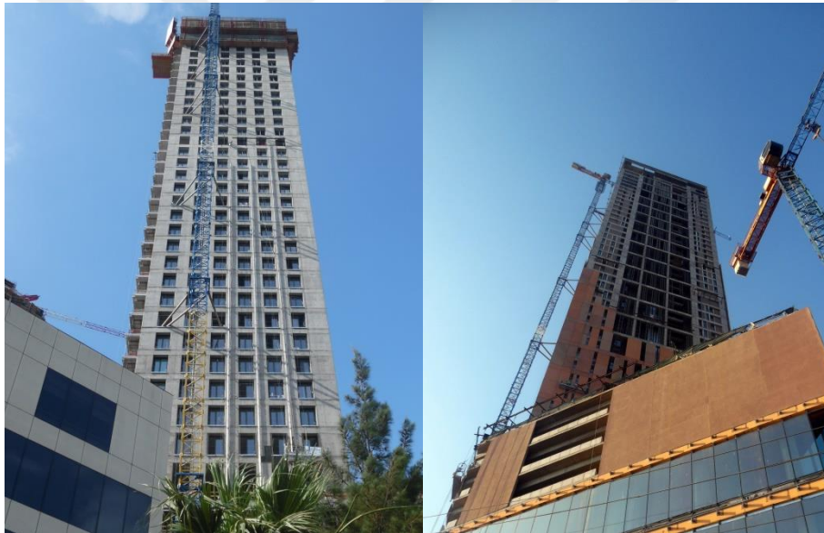
Şekil 6.25. Ege Perla Konut Kulesi Bina Yapım Aşaması (URL60)
