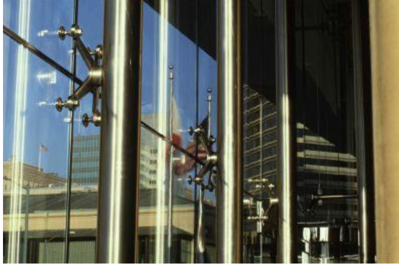
Şekil 5.30. Transparan cephe sisteminde boyutlarına göre bağlantı elemanları (MEB, 2012)
