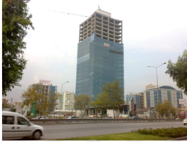
Şekil 6.5. Bayraklı Tower Yapım Aşaması (URL49)
