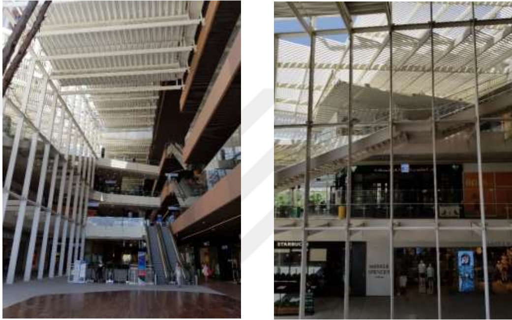
Şekil 4.31 Ege Perla yapısında kullanılan gölgeleme elemanları (Kişisel arşiv, 2020)
