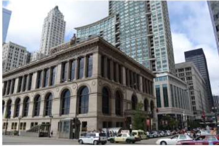
Şekil 3.12 Yüksek yapının giriş kat yüksekliği bakımından çevre binalarla uyumuna bir örnek. Chicago, ABD (Kodmany, 2012)
