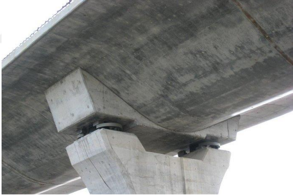
Şekil 10. Köprülerde sismik izolatörüm uygulanması
