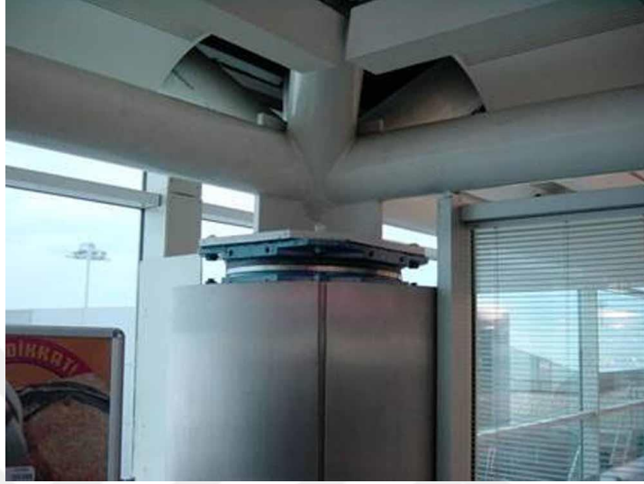
Şekil 6. Sürtünmeli sarkaç sismik izolatörü
