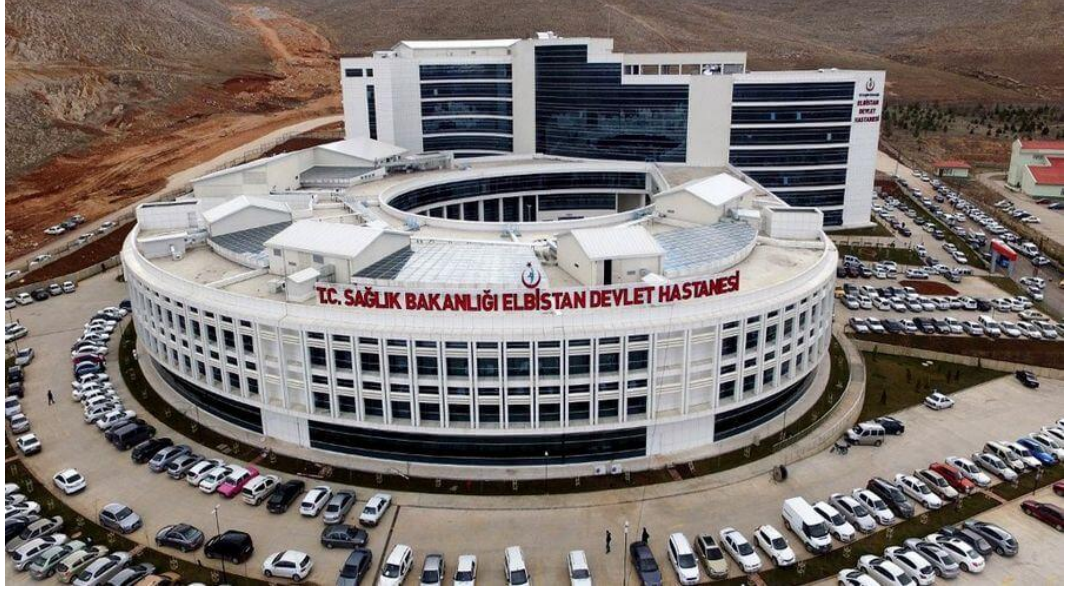
Şekil 8. Elbistan devlet hastanesinde sismik izolatörün uygulanması
