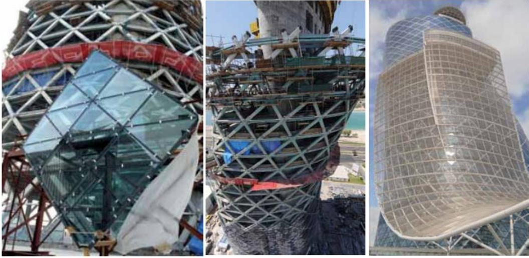
Şekil 2.26 Capital Gate Cephe Detayları [21]
