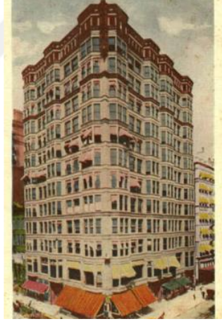
Şekil 3.7 Tacoma Binası (Toprakal, 2008)
