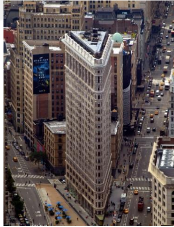
Şekil 3.9 Flatiron Binası (skyscrapercenter, 2021)
