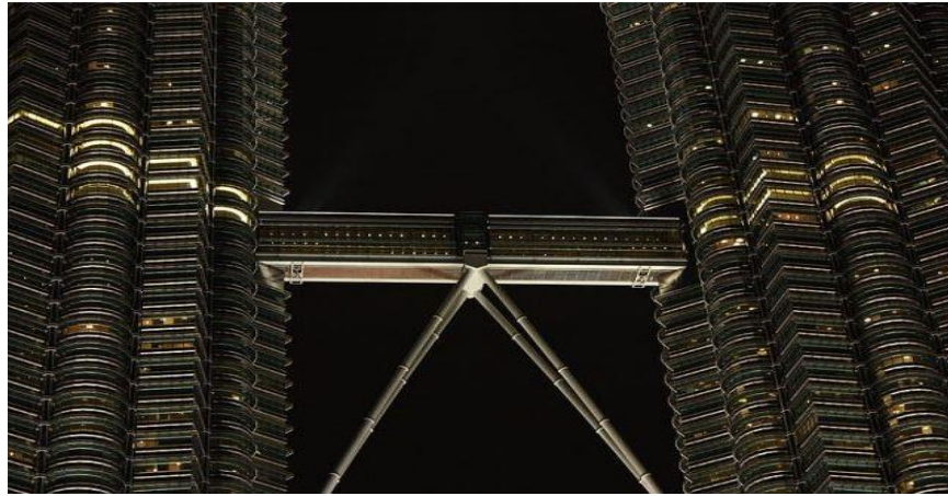
Şekil 3.9. Petronas Towers 41 ve 42. katlarında bulunan çelik köprü görseli
