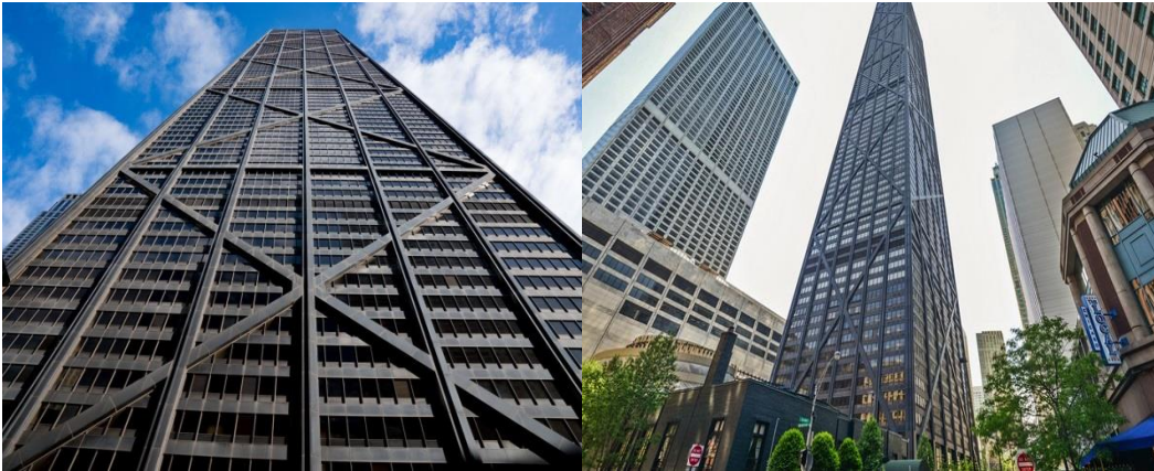
Şekil 3.34. Kafes tüp sistem gösterimi John Hancock binası
