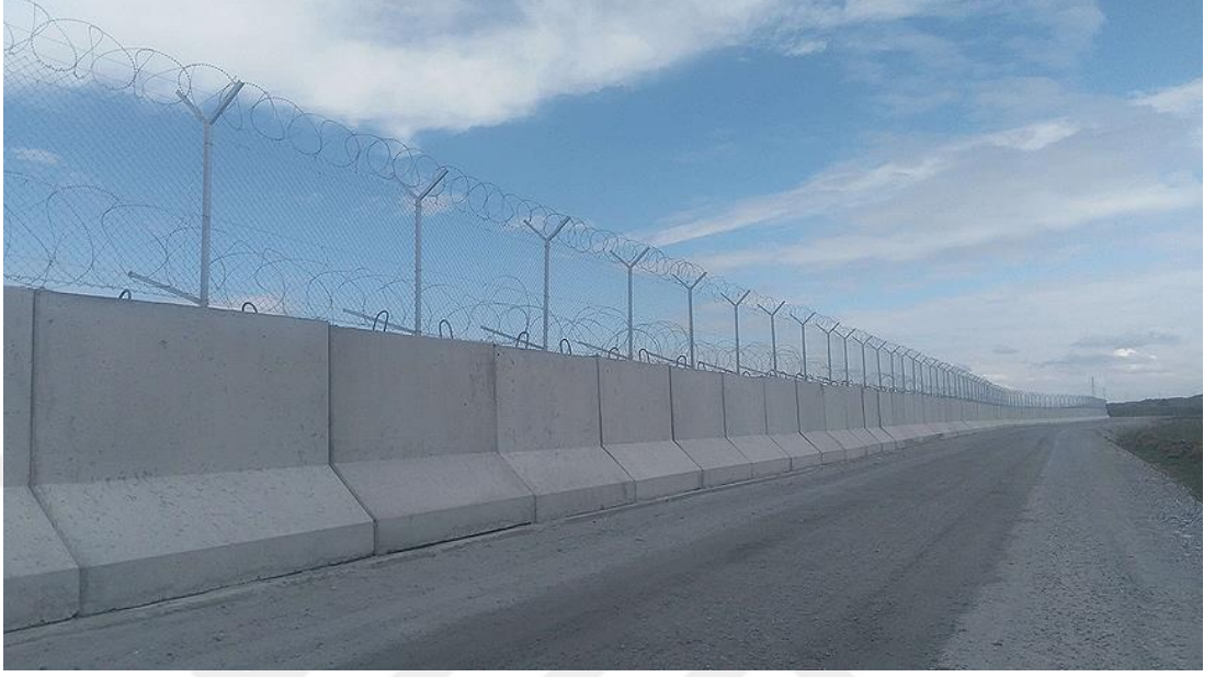
Resim 3: Türkiye'nin Suriye'den Geçişleri Durdurmak İçin İnşa Ettiği Sınır Duvarı
