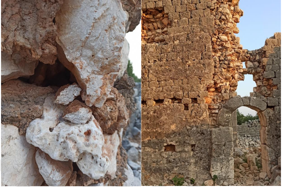
Şekil 2.1. Kanlıdivane ören yeri horasan harcı kullanımı.
