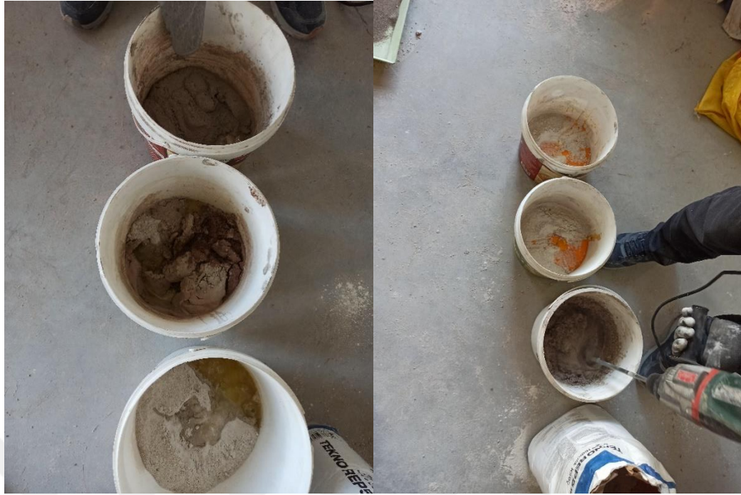
Şekil 3.8. Doğal hidrolik kireç harcının karıştırılması.
